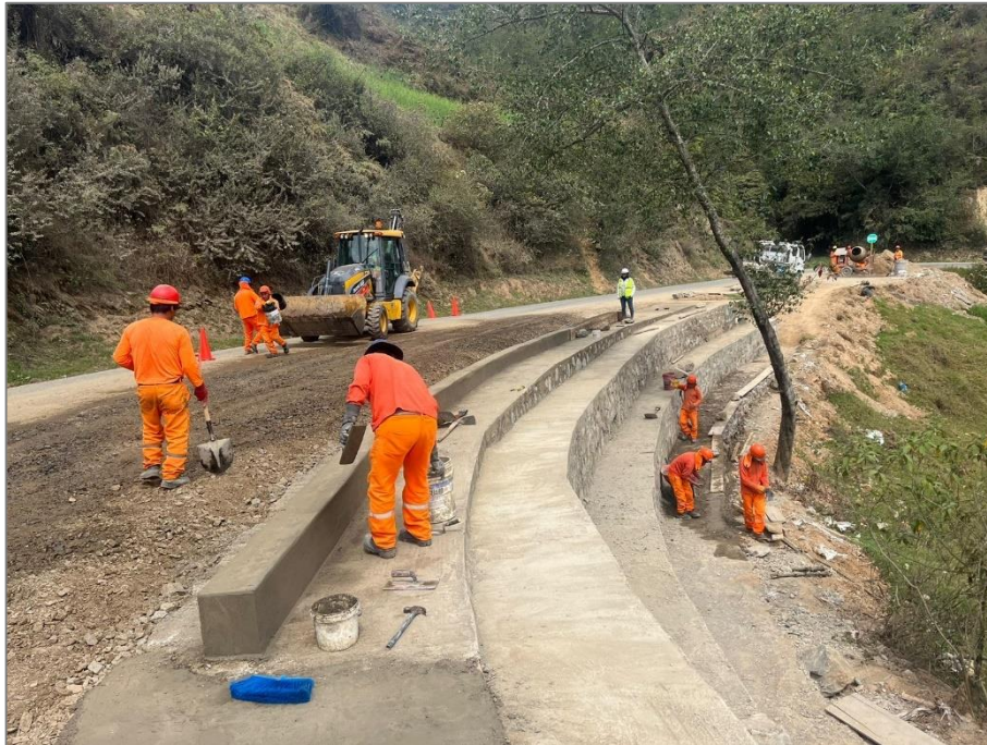
Nota. Relleno y compactación de plataforma.
