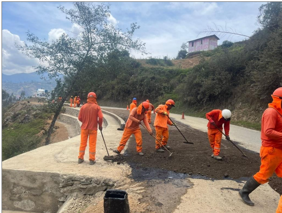
Nota. Imprimación de calzada.
