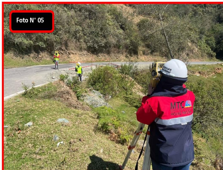
FOTO N° 05: Se observa la el levantamiento de puntos del eje de carretera y los bodes de talud.
