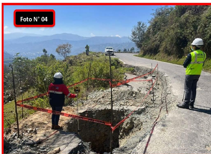
FOTO N° 04: Se observa la calicata y la toma del punto respectivo.
