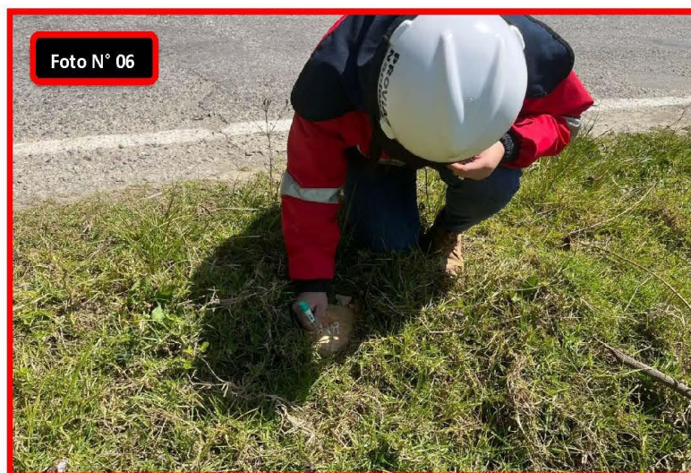
FOTO N° 06: Se observa la colocación de puntos de referencia para realizar un cambio de estación.
