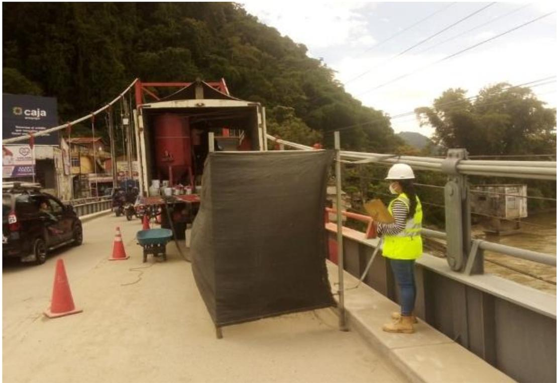
**Verificación de la actividad arenada en superficies estructurales en el puente Corpac**
