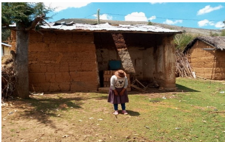
Figura 10 Vivienda de tapial típica de la zona
