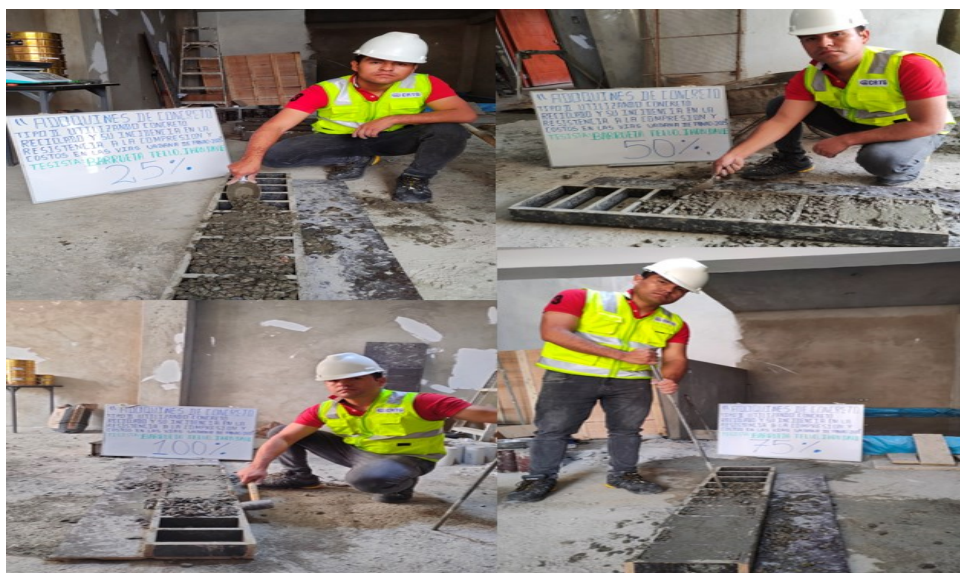
Figura 7 Elaboración de los adoquines tipo II con adición de concreto reciclado en un (25, 50, 75 y 100)%
