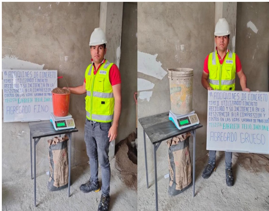
Figura 5 Pesaje de los agregados finos y gruesos
