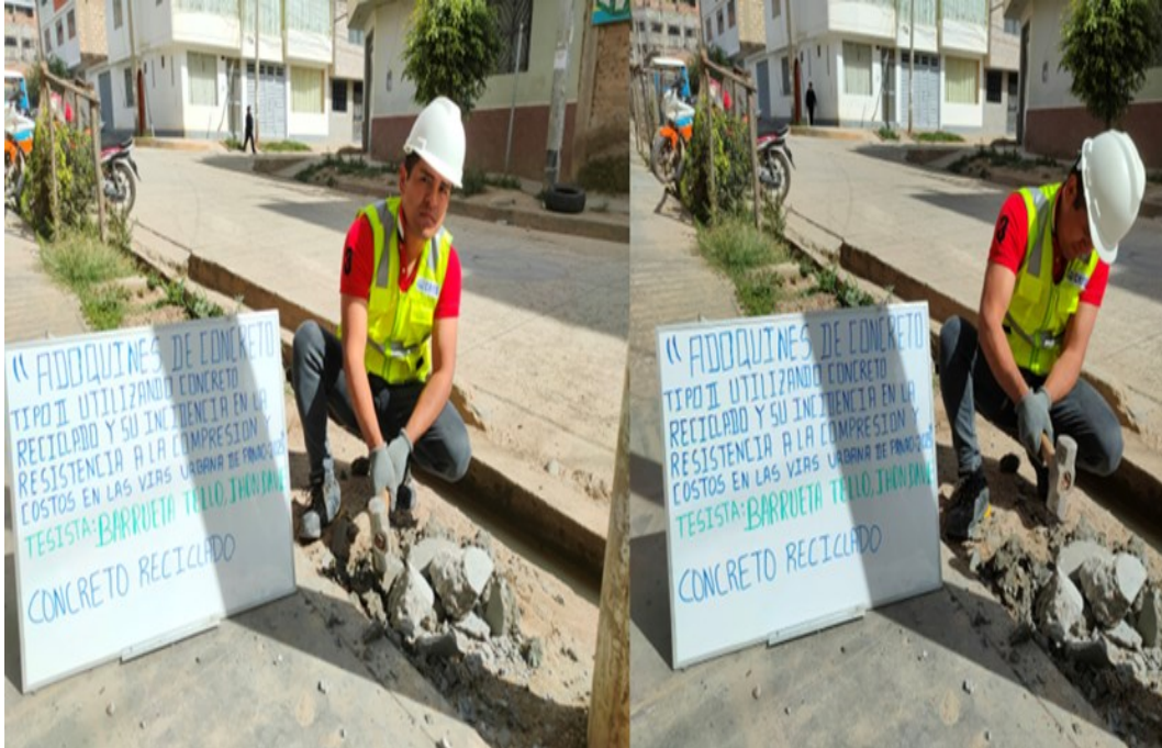
Fotografía 1 Recolección de concreto reciclado
