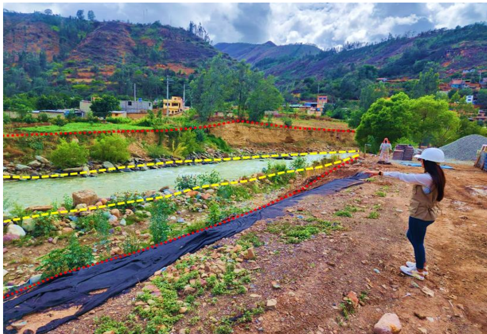
Descubrimiento de posibles indicios de deslizamientos
