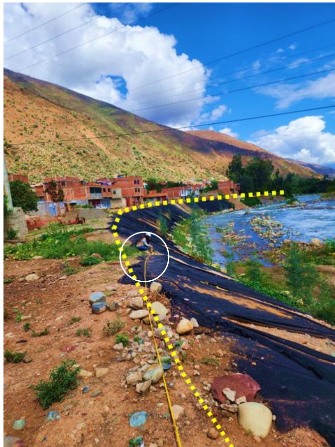
Medición de la margen del río
