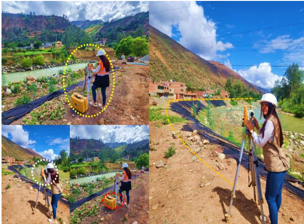
Ensamblaje de equipo topográfico
