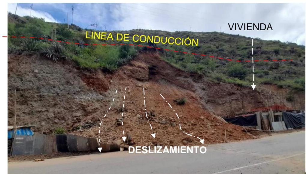
Las figuras 28, 29 y 30 a continuación representan el perfil donde se encuentra ubicada la vivienda en construcción, vivienda que ha ocasionado en su proceso constructivo erosión de las laderas. En la figura 27 se aprecia el corte en el tramo 00+020.00 según el plano topográfico del mismo estudio, se visualiza la línea de conducción y la vivienda ubicada a casi 10 metros en la
