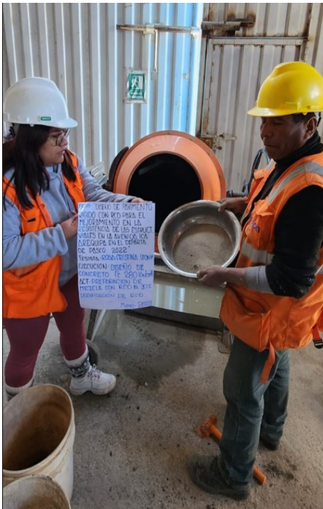
Fotografía 25 Preparación de la mezcla con RCD al 30%
