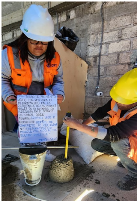
Fotografía 13 Preparación de la mezcla con RCD al 0% (control de asentamiento, Slump 4")
