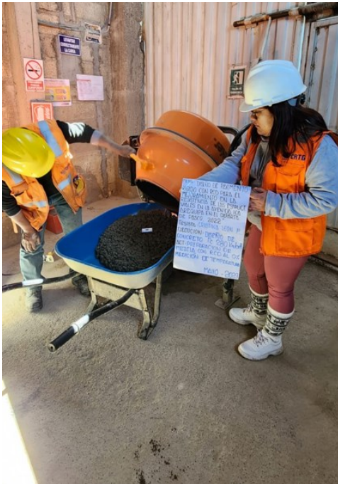
Fotografía 12 Preparación de la mezcla con RCD al 0% (medición de temperatura)
