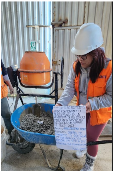
Fotografía 26 Preparación de la mezcla con RCD al 30% (medición de temperatura)
