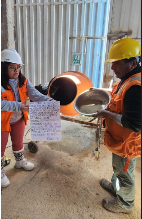
Fotografía 19 Preparación de la mezcla con RCD al 20%
