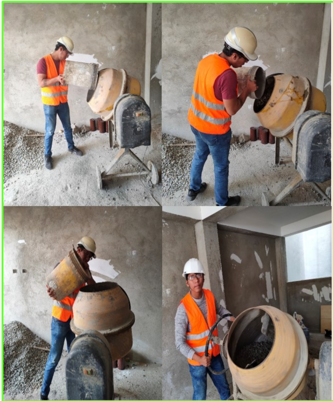
Figura 29 Elaboración del concreto patrón
