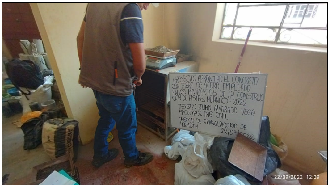
SE OBSERVA EL PESADO DE AGREGADO PARA LOS ENSAYOS DE GRANULOMETRIA.
