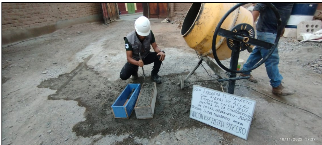
SE OBSERVA EL LLENADO DE MEZCLA EN VIGA Y CHUZEADO
