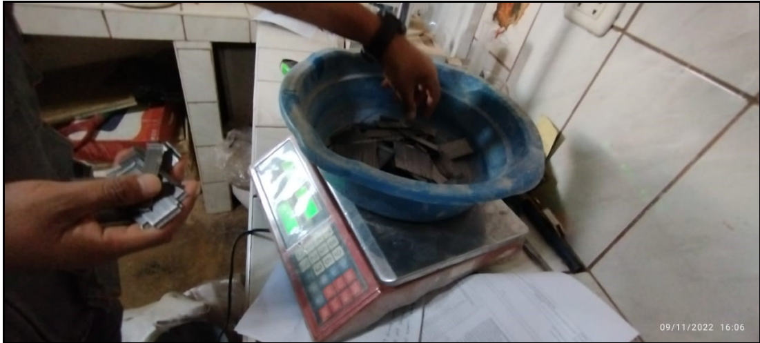
SE OBSERVA EL PESADO DE LA FIBRA DE ACERO SEGUN DISEÑO
