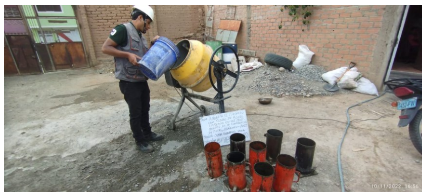
SE OBSERVA LA FABRICACIÓN DEL CONCRETO Y PUESTA EN TESTIGOS
