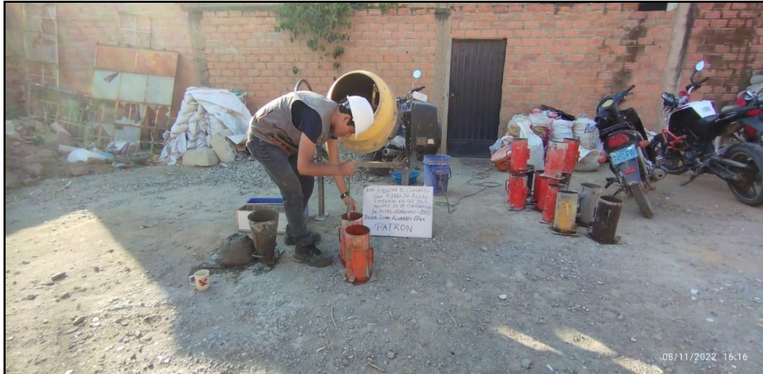
CHUZEADO DE CONCRETO EN FABRICACIÓN DE TESTIGOS CON ESPECÍMENES DE ADHESIÓN.
