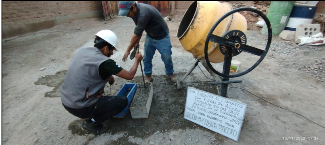
LLENADO Y CHUZEADO DE MEZCLA EN VIGAS
