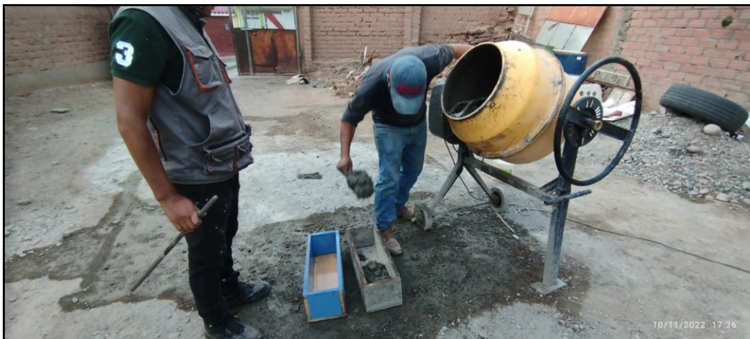
SE OBSERVA EL LLENADO DE MEZCLA SEGUN DISEÑO EN VIGAS
