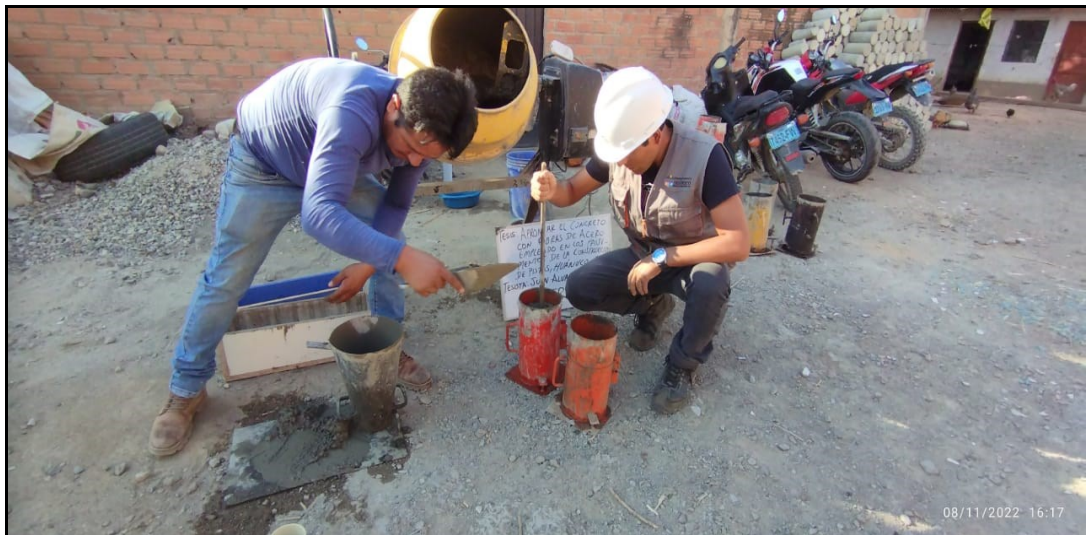
CHUZEADO DE CONCRETO EN EL ELABORACIÓN DE TESTIGOS CILÍNDRICOS.
