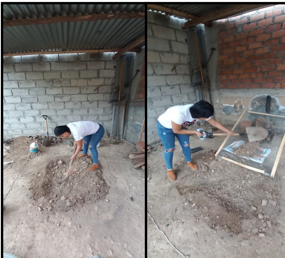
Figura 5 Cerniendo la tierra para luego plantar la vetiveria
