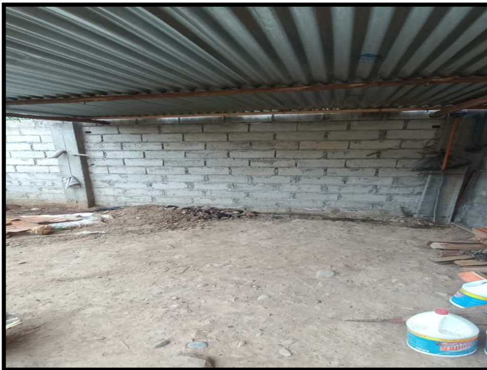
Figura 4 Acondicionamiento de lugar
