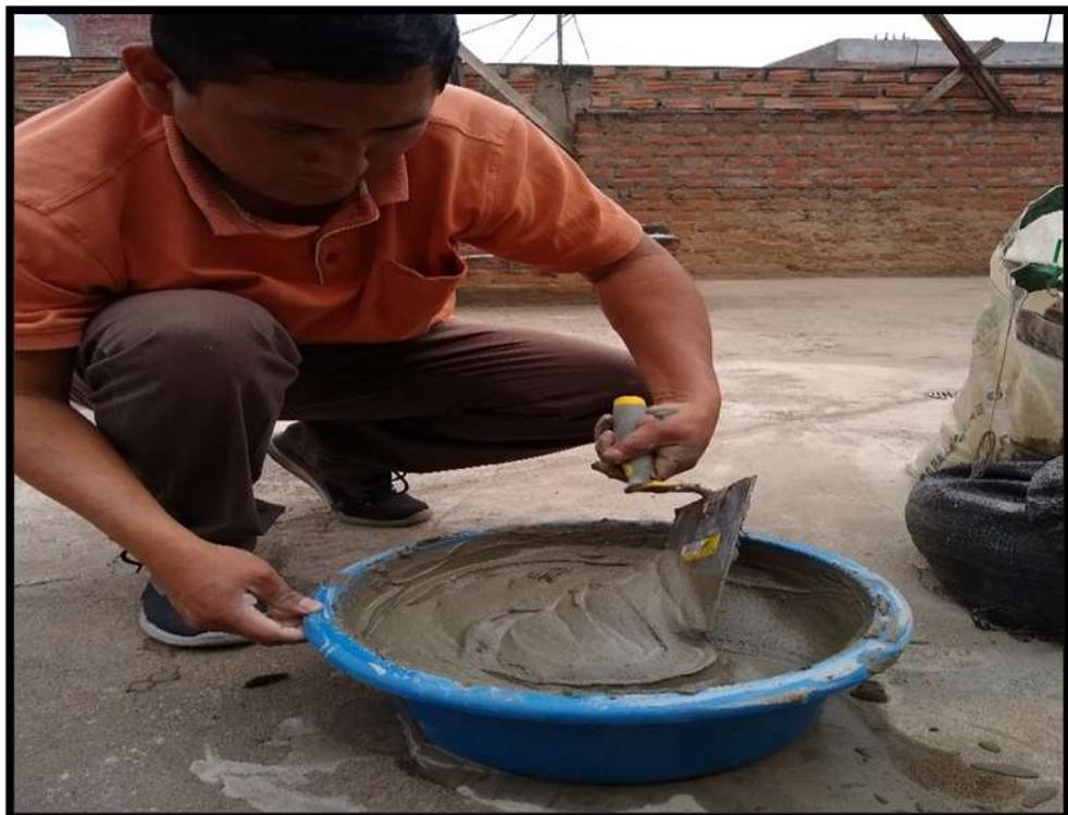
Preparación de la mezcla con plástico finamente triturado
