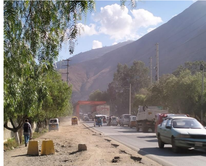
MEJORAR LA SEGURIDAD DE LAS CARRETERAS
