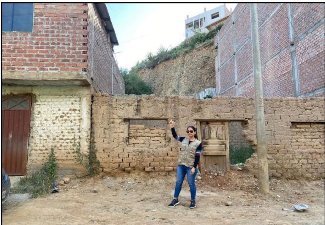
Vista frontal de ladera 02, ubicado en la progresiva 0+388 del Asentamiento Humano Leoncio Prado Gutiérrez.
