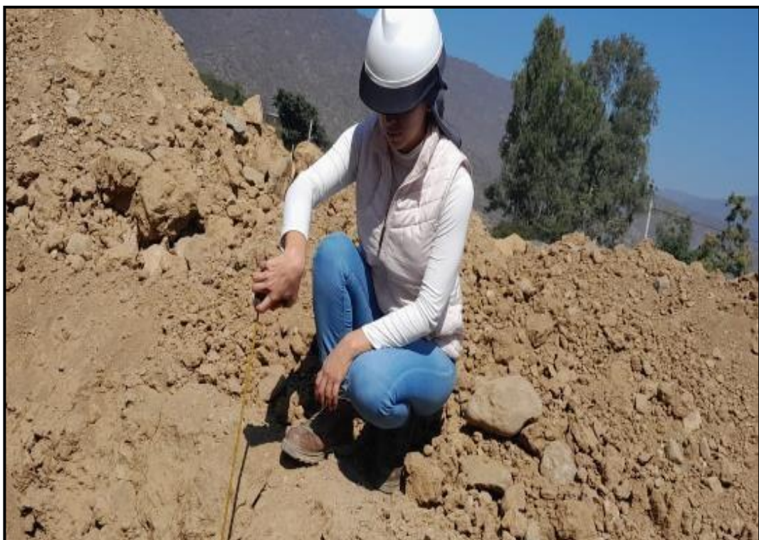
Verificación de profundidad de Calicata 01 ubicado en la progresiva 0+282.
