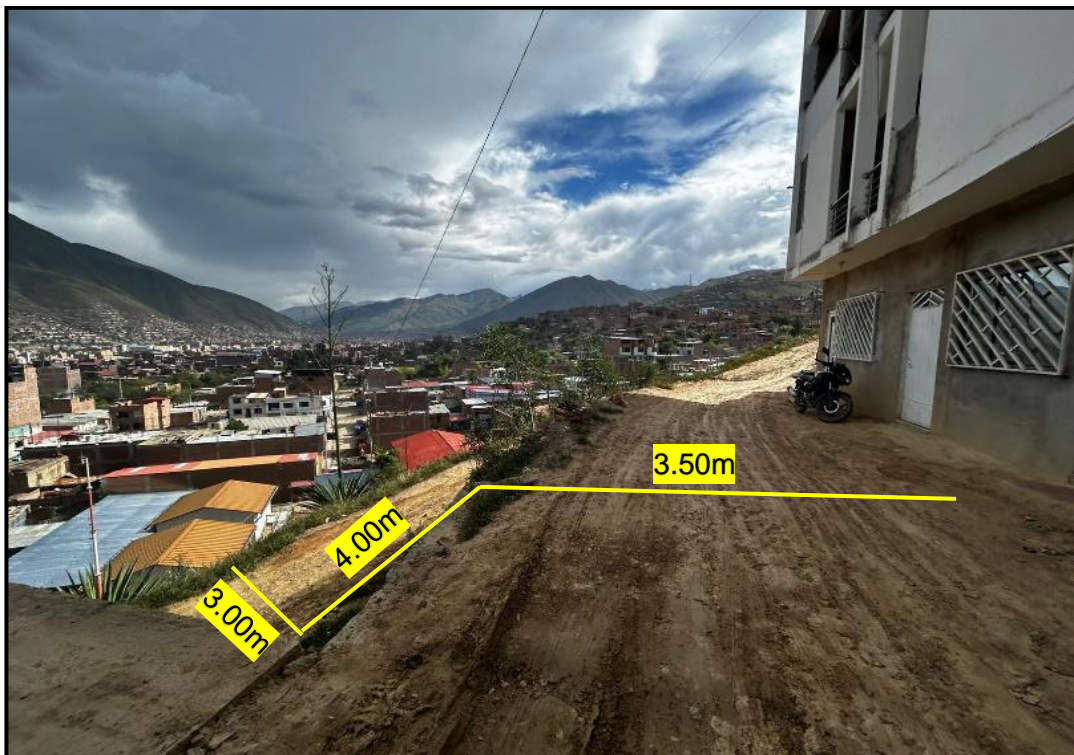
Vista de la Zona donde se extrajo la segunda muestra, como se observa, existen 2 taludes, el primero de 4m de altura con un ancho de vía de 3.50m y el segundo talud de 16m de altura y un ancho de vía de 3m.
