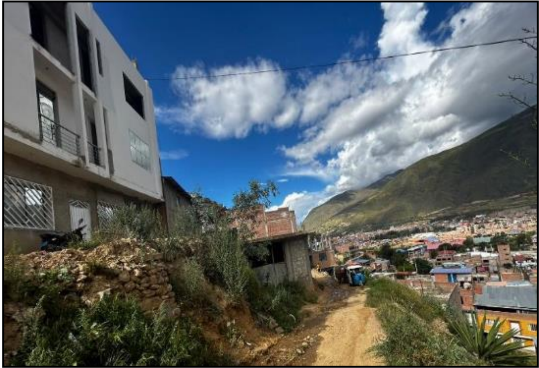
Las viviendas sostienen sus taludes con pircas de piedra, es decir piedras con junta seca de construcción artesanal.
