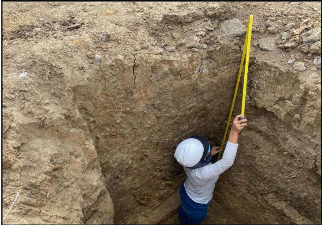
Medición de profundidad de Calicatas.
