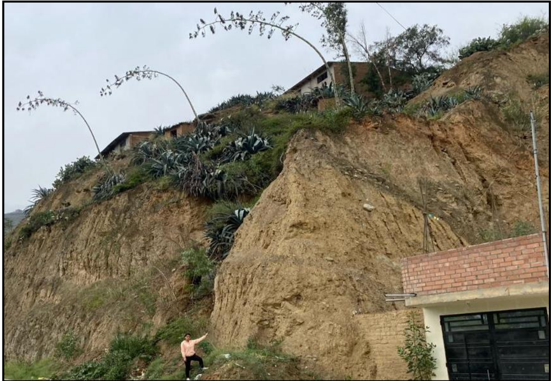
Vista frontal de ladera 03, ubicado en la progresiva 0+485 del Asentamiento Humano Leoncio Prado Gutiérrez.
