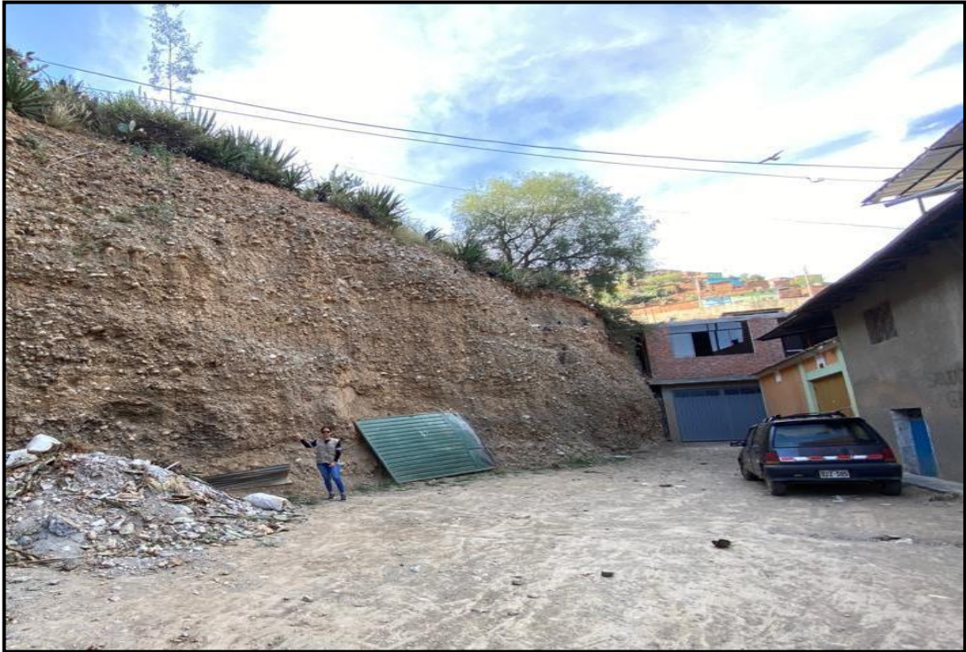
Vista frontal de ladera 01, ubicado en la progresiva 0+282 del Asentamiento Humano Leoncio Prado Gutiérrez.
