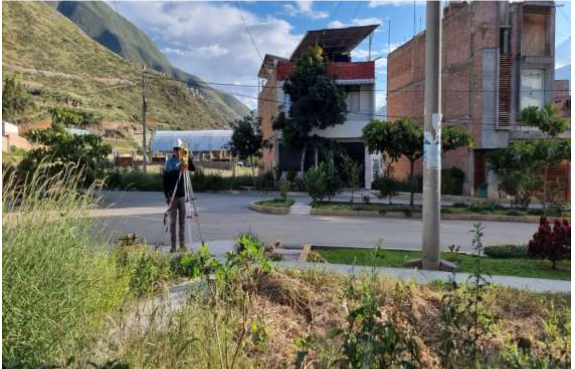
La imagen muestra el inicio de la toma de puntos del perímetro del terreno, de las viviendas colindantes, de las calles, veredas, postes de energía eléctrica, sardineles y otros componentes más del lugar.
