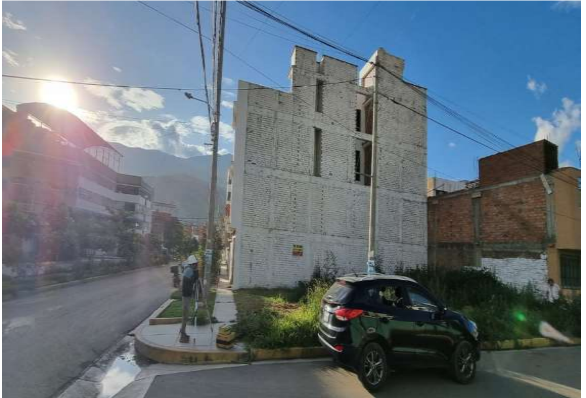
La imagen muestra la toma de puntos de las viviendas colindantes, y las características del Jr. Los Portales.
