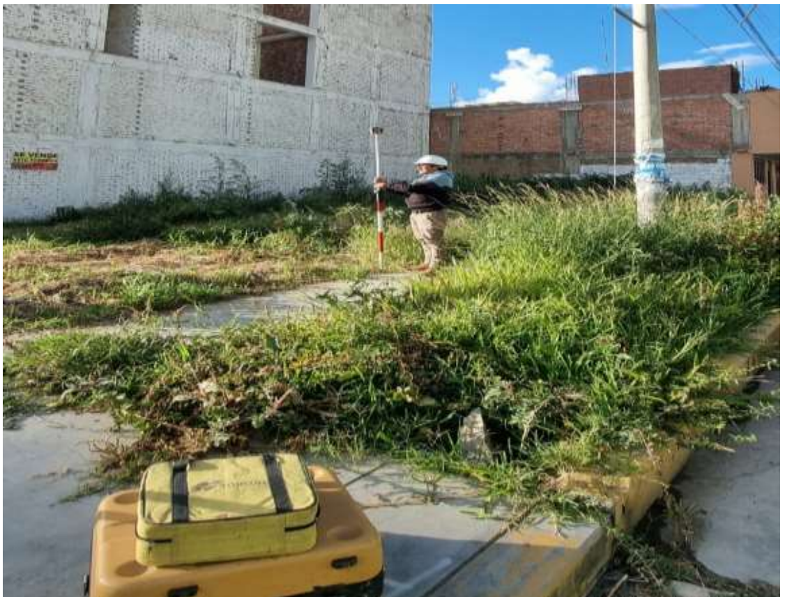
La imagen muestra el control de la altura del prisma para iniciar con la toma de puntos del levantamiento topográfico.
