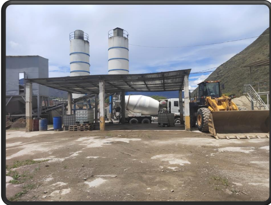
Vehículo mixer, esperando carga de concreto para realizar su entrega de pedido.
