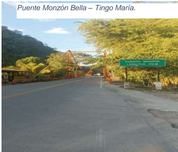
Medidor de caudal en puente Monzón Bella.
