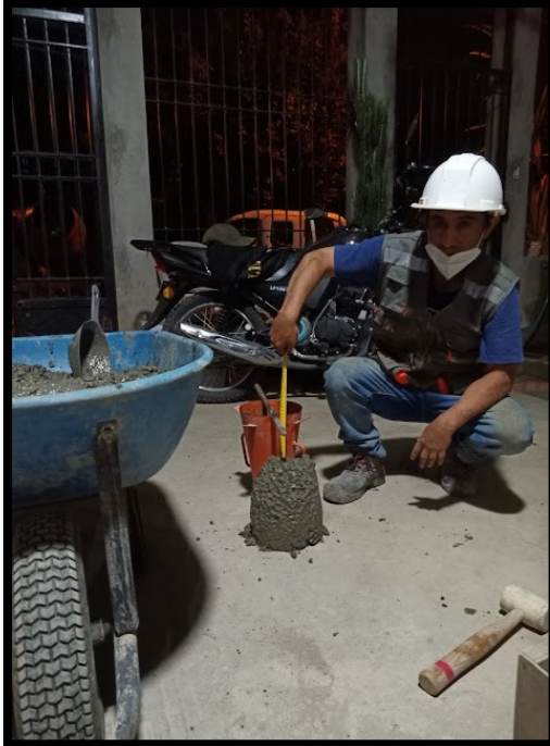
Fotografía 28 Asentamiento cemento Andino (slump) 5"
