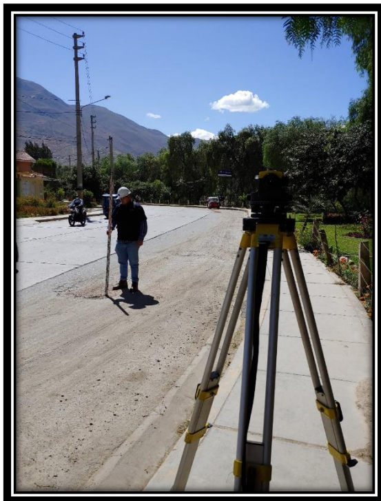
Se observa al asistente de campo sosteniendo la mira topográfica.
