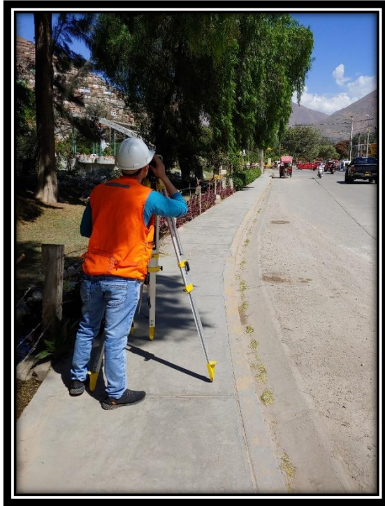
Se observa al tesista realizando la nivelación topográfica el día 02.
