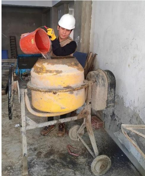
Nota: Proceso de elaboración del concreto con una resistencia  $f'c=210\text{kg/cm}^2$  como lo indica la normativa ACI 211 donde el agua tiene que ser libre de impurezas (agua potable) según la NTP 339.088.
