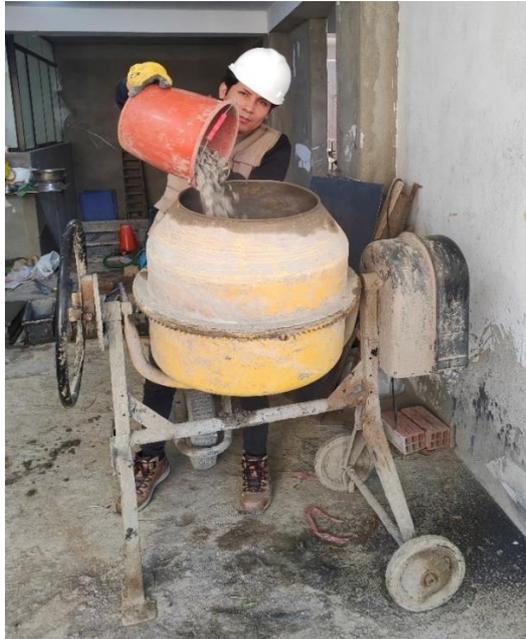
*Nota: Proceso de elaboración de la dosificación del concreto como lo indica la norma ACI 211, agregado grueso tamaño máximo nominal 3/4" según la NTP 400.012.*
