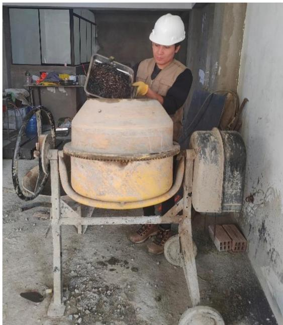
*Nota: Proceso de elaboración del concreto como lo indica la norma ACI 211, se usará la adición 7% de virutas metálica para la elaboración de las muestras de vigas para ser ensayadas según la NTP 339.079.*
