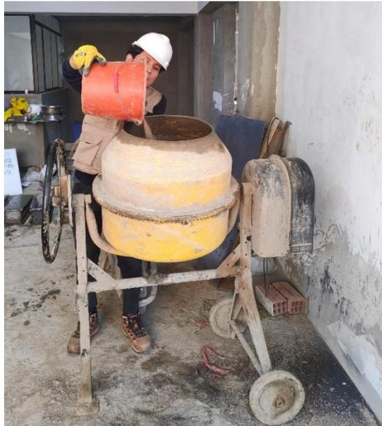
*Nota: Proceso de elaboración de la dosificación del concreto como lo indica la norma ACI 211, agregado fino tamaño máximo nominal N° 4 según la NTP 400.012.*
