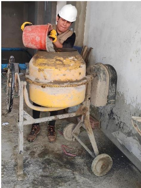
Nota: Proceso de elaboración del concreto con una resistencia  $f'c=210\text{kg/cm}^2$  como lo indica la normativa ACI 211 donde se usa el cemento tipo I especificado en la NTP 334.009.
