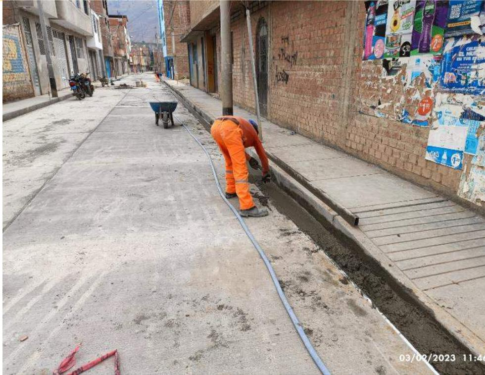
SE PUEDE VISUALIZAR EL VACIADO DE CUNETAS DE CONCRETO
