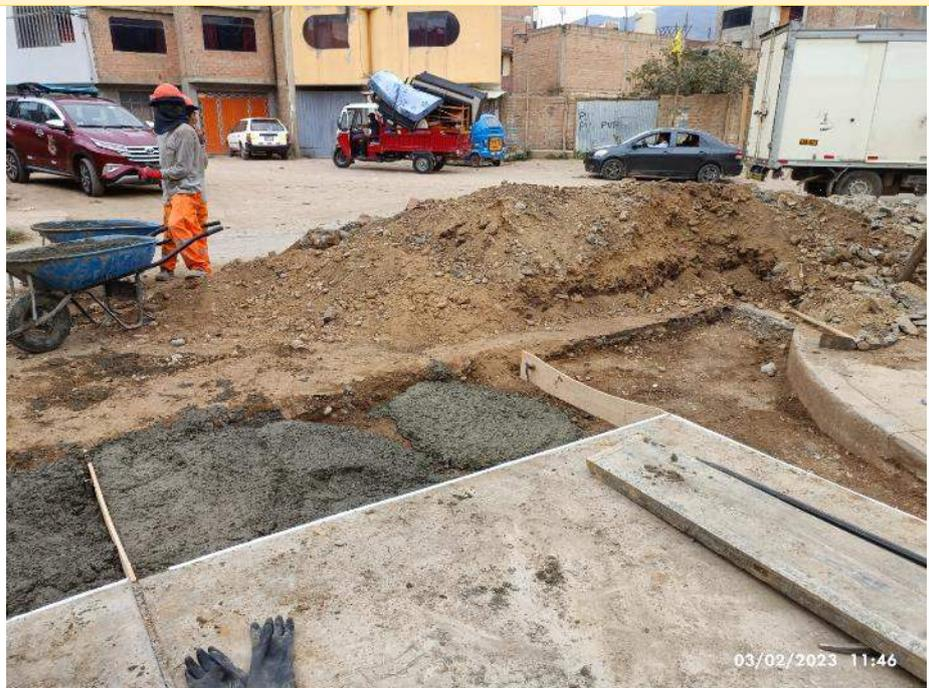
SE PUEDE VISUALIZAR EL VACIADO DE CONCRETO EN CUNETAS DE CONCRETO FC=175 KG/CM2
