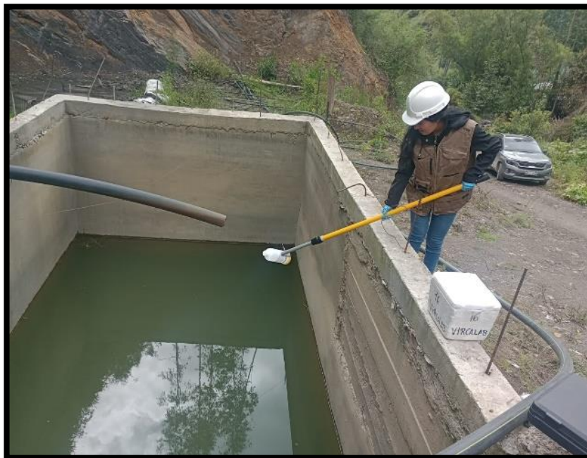
Toma de muestra del reservorio de recirculación de la PTARI
