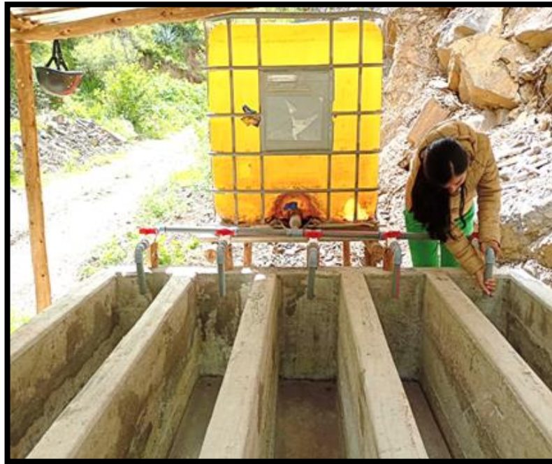
Instalación del sistema tuberías
