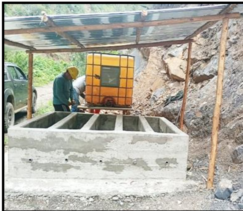
Instalación de techo y colocación del tanque
