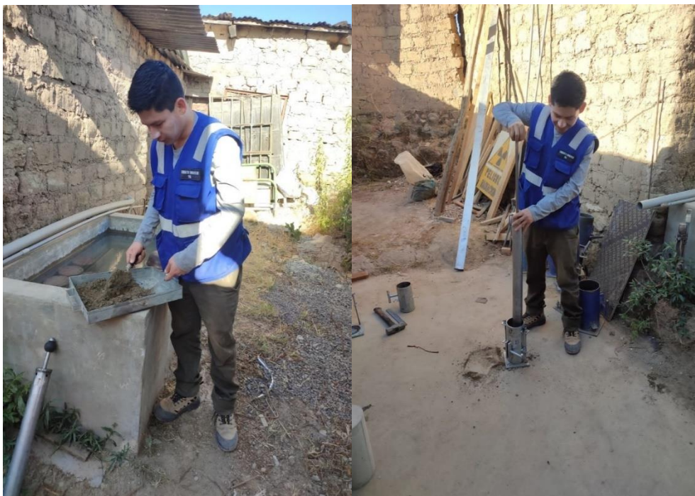
Fotografía 20 Mezclado y moldeo
