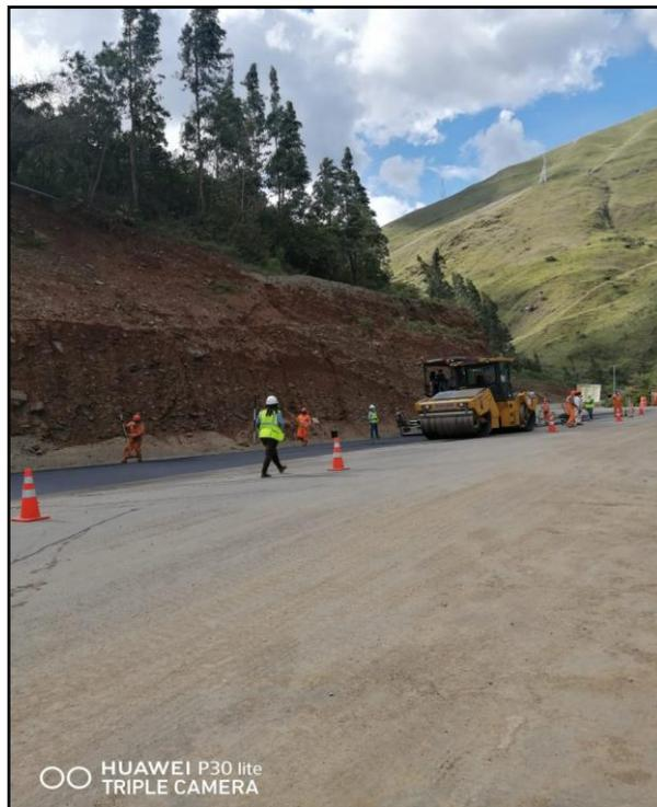
**RETRATO N° 08:** Control de productividad en colocación de asfalto (Tramo 1 – Km. 13)
