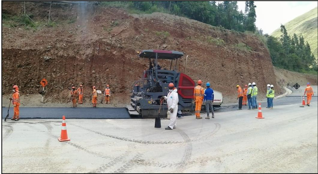
**RETRATO N° 09:** Control de productividad en colocación de asfalto (Tramo 1 – Km. 13)
