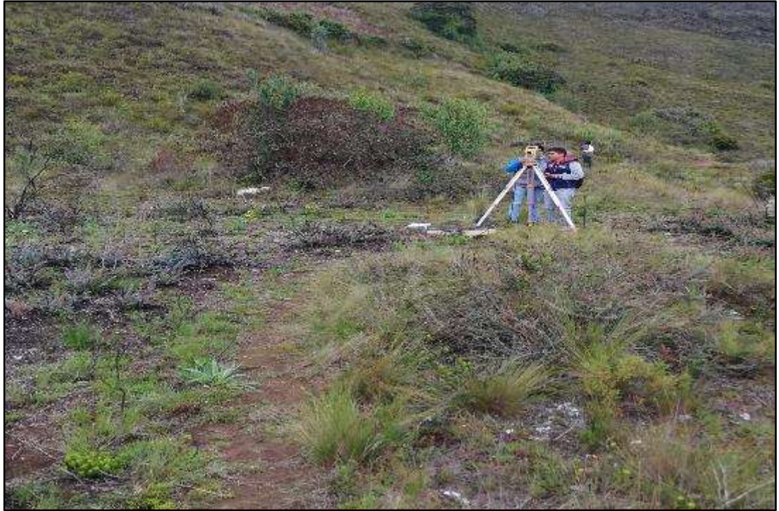
Se muestra el estacionamiento del equipo South N7 para realizar el levantamiento topográfico
