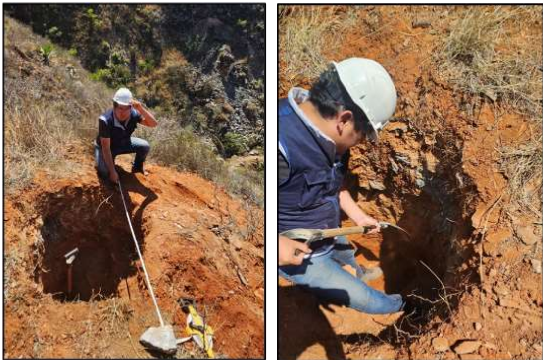
Excavación y Dimensionamiento de la calicata
