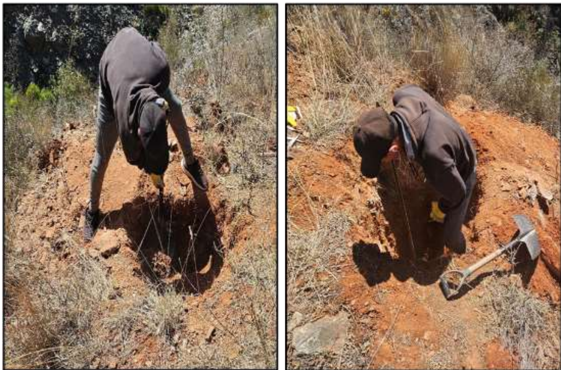
Preparación del terreno para la excavación de la calicata
