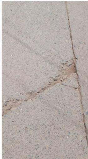
FALLA 19 Descascaramiento de Junta M
