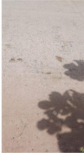
FALLA 11 Pulimiento de Agregados M
