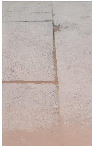
FALLA 05 Escala M (3 paños), FALLA 11 Pulimiento de agregados M
