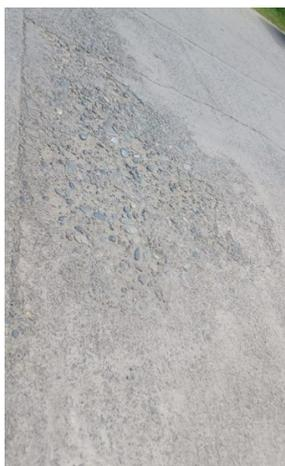
FALLA 03 Losa Divivida M, FALLA 11 Pulimiento de Agregados M
