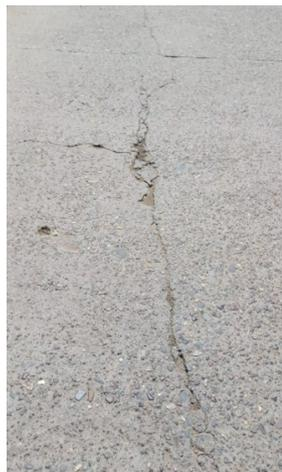
FALLA 08 Grietas Lineales M, FALLA 11 Pulimiento de agregados M
