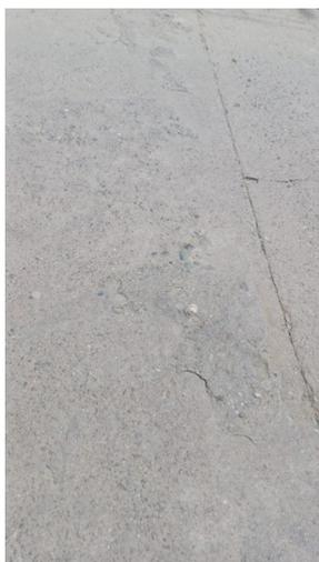
FALLA 11 Pulimiento de Agregados B
