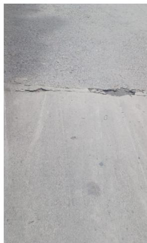
FALLA 19 Descascaramiento de Junta B
