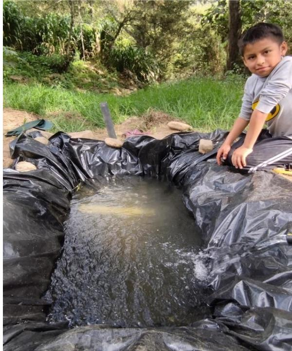
Prueba de impermeabilidad con membrana impermeabilizante de plástico
