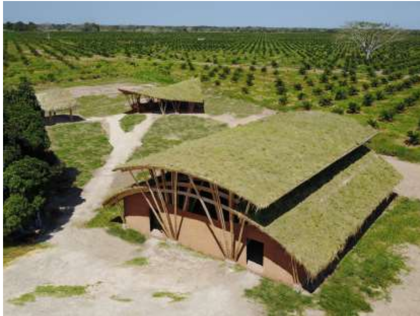
Figura 90 Bambú usado en proceso constructivo
