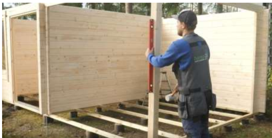
Figura 89 Madera usada en proceso constructivo
