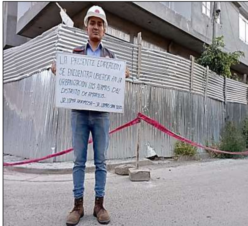
FACHADA VERTIVAL DE EDIFICACION.
