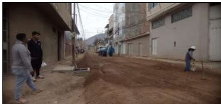
La utilización de la cisterna para el riego en los trabajos
