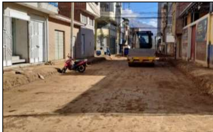
Preparación del terreno , Compactación de la cuadra 18
