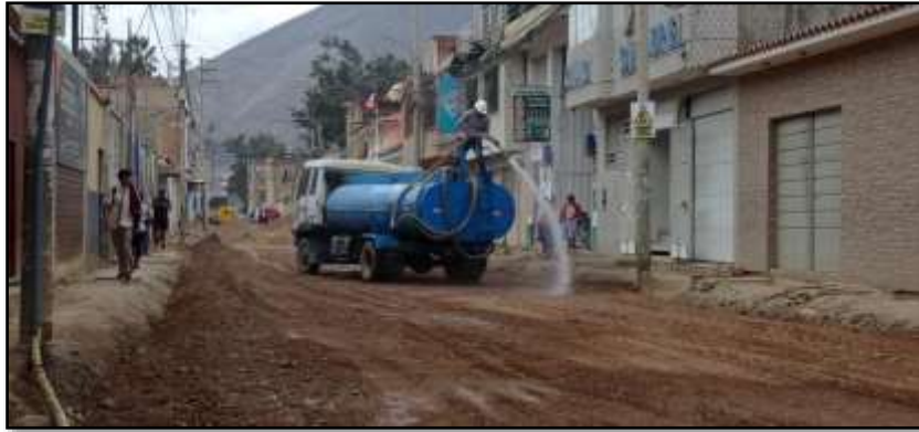
Uso de la cisterna para el riego en la rehabilitación de las pistas y veredas en la obra.
