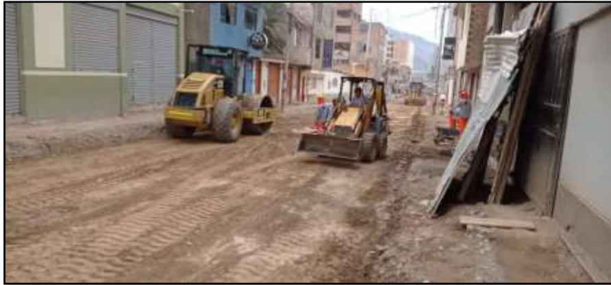
Compactación del terreno así se aumenta su densidad
