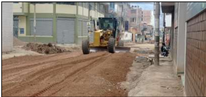
El uso de la motoniveladora en los trabajos de rehabilitación de pistas y veredas
