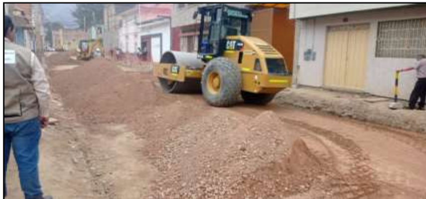
Mejora de la estabilidad y resistencia del suelo al compactar el terreno
