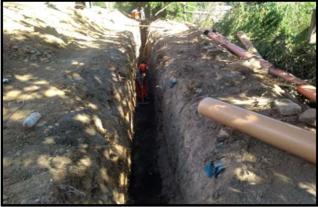
19: Se puede notar en la fotografía la zanja ya excavada, terminada y perfilada en una altura de 1.70 m.
