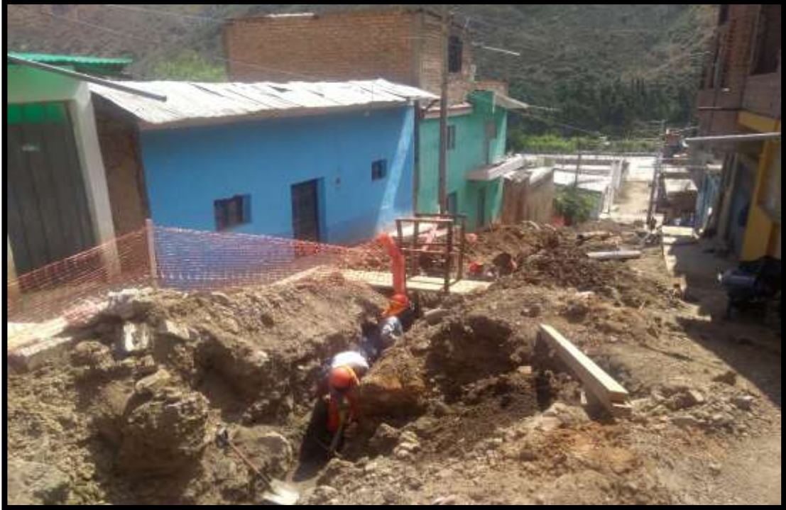
25: Se puede ver en la fotografía que se realizan los trabajos de excavación de zanja en una altura de 1.40 m en el frente de trabajo del centro de ambo.
