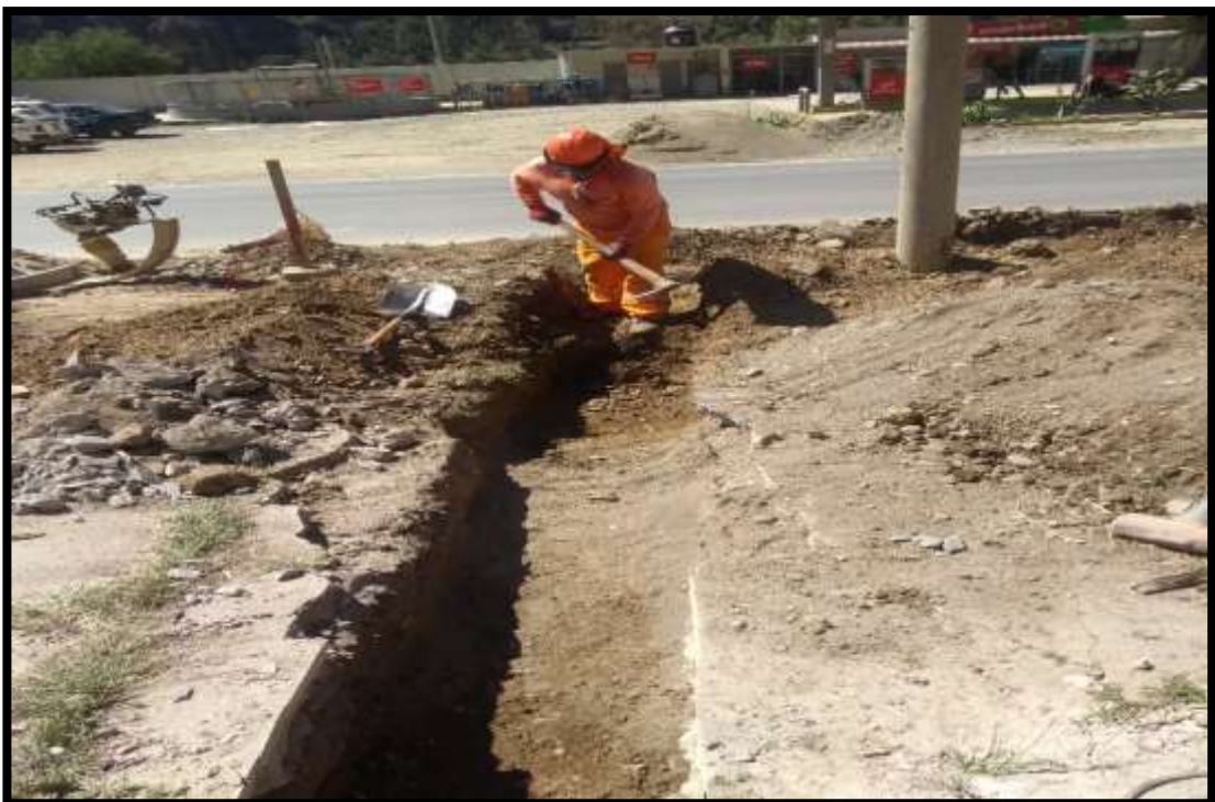
16: Se puede observar en dicha fotografía que se realizan los trabajos de excavación en terreno normal en el frente de trabajo coterá.
