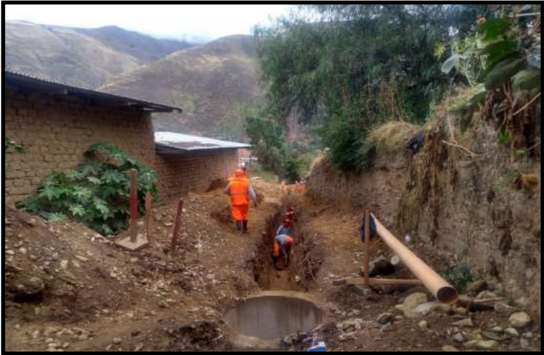
21: Se puede apreciar en la fotografía el orden y limpieza al borde las zanjas para evitar la caída del material excedente que sería perjudicial para los trabajos que se realizaron.
