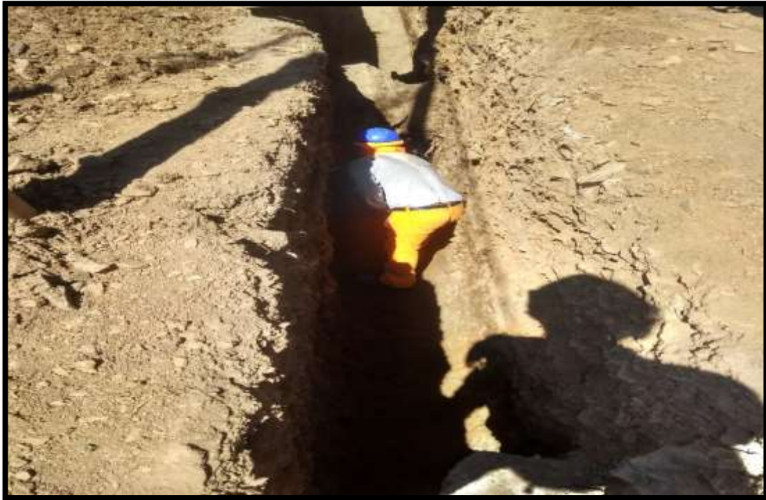
17: Se puede ver en la fotografía que el personal obrero se encuentra realizando trabajos de excavación en una altura de 1.70 m.
