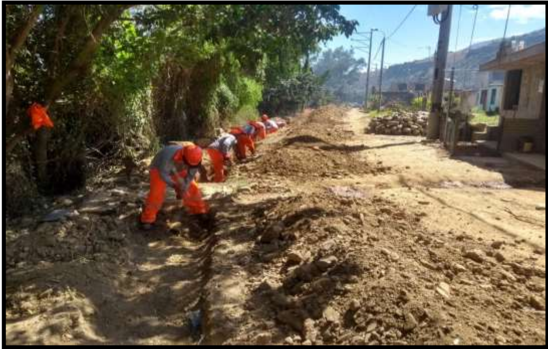
11: Se puede ver en la fotografía que el personal obrero se encuentra con los EEP, así mismo realizando los trabajos de excavación.
