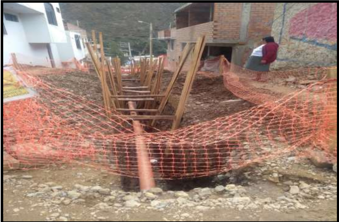
22: Se puede apreciar en dicha fotografía los trabajos de entibado, ya que la zanja tiene una altura de 1.70 m.
