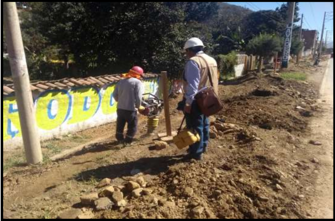
7: Se puede observar al personal técnico ingeniero de campo, supervisando los trabajos de excavación y compactado de las zanjas.
