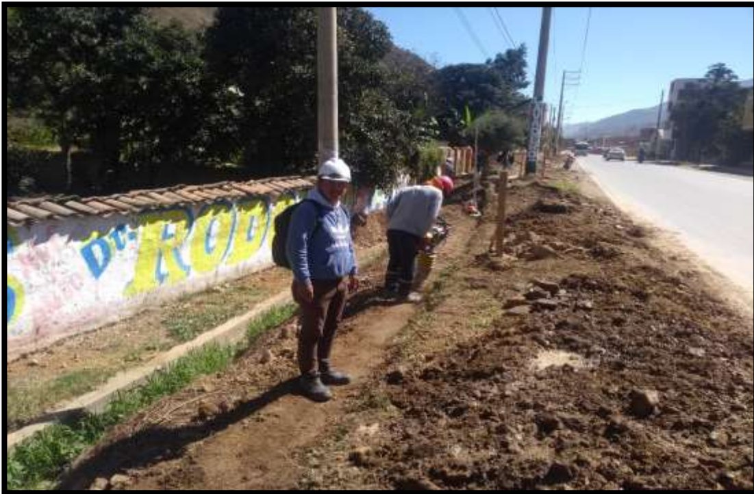
8: Se puede apreciar en la fotografía los trabajos de compactado y excavación de zanjas.
