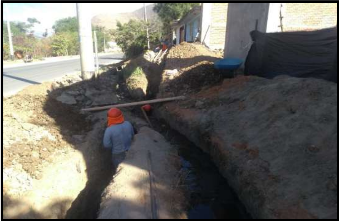
15: Se puede apreciar en la fotografía los trabajos de excavación en el frente de trabajo coterá.
