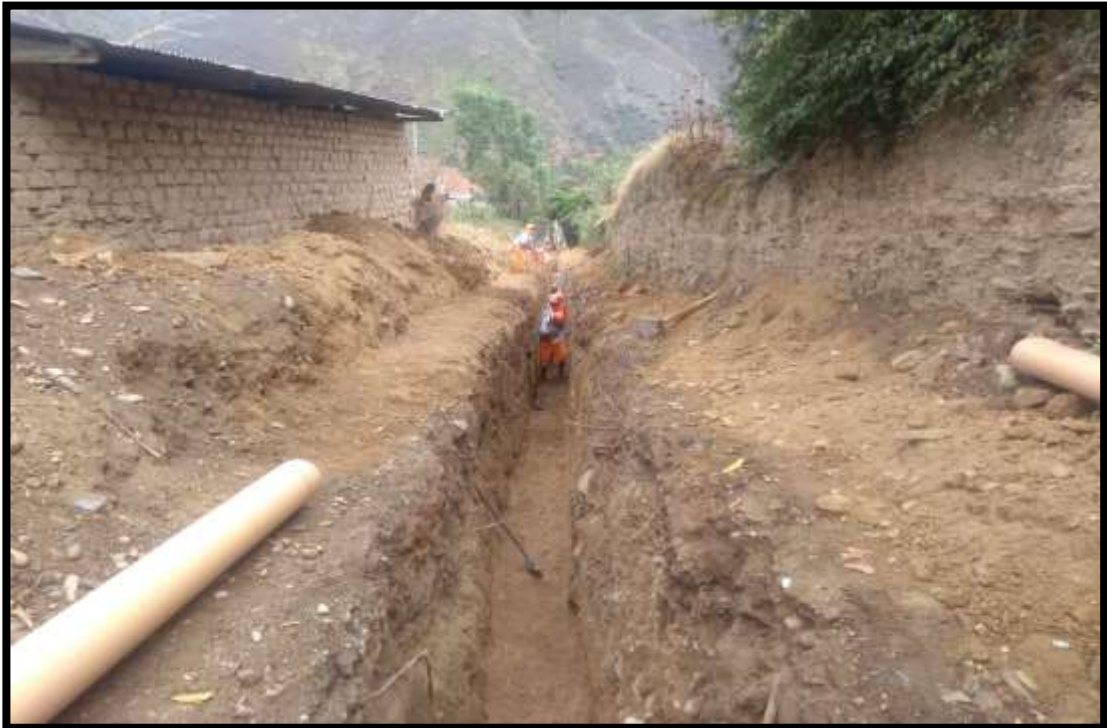
20: Se puede observar en la fotografía las excavaciones de zanja en alturas de 1.40 m, en el frente de trabajo de Andahualla.
