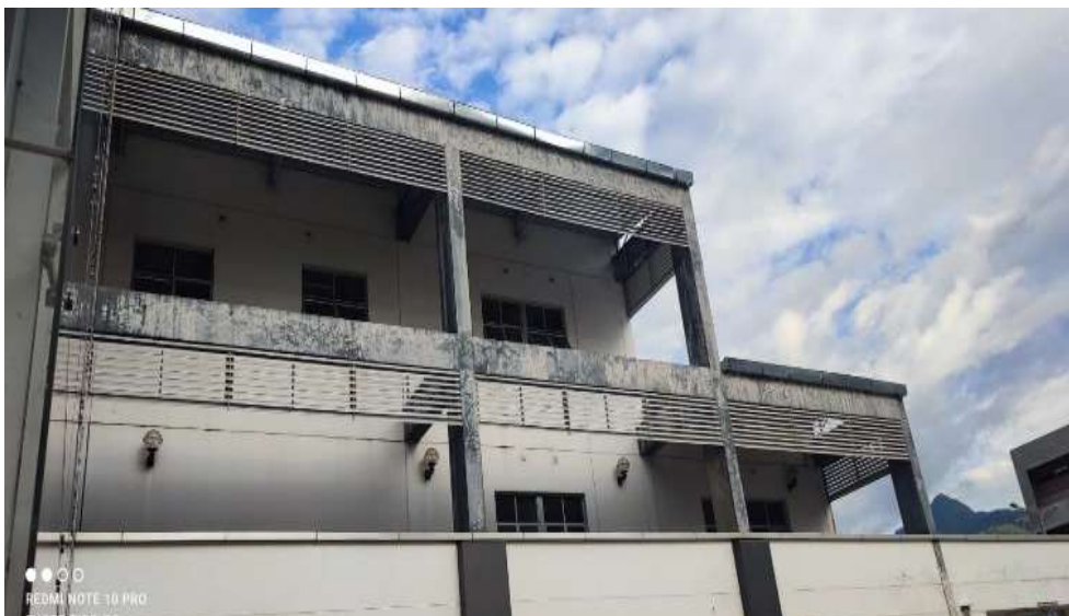
Reconocimiento Preliminar de la Infraestructura Hospitalaria
