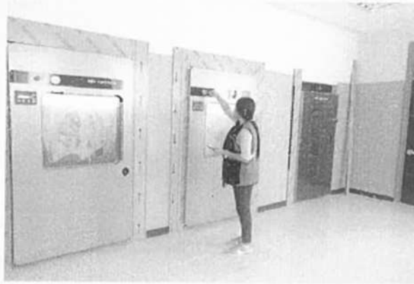
FOTOGRAFIA N° 001 – RECONOCIMIENTO PRELIMINAR DE LAS ZONAS DEL ESTABLECIMIENTO DE SALUD
