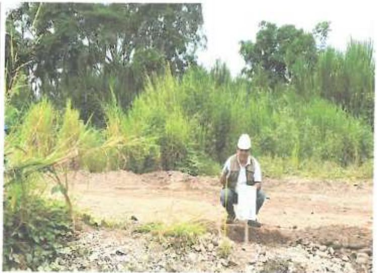
FOTOGRAFÍA N° 02: vista fotográfica del procedimiento de exploración y recolección de muestras correspondientes a la calicata C-02
