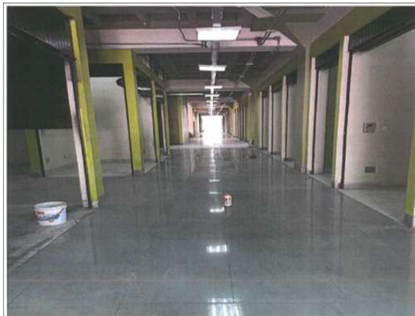
Se observa el interior después de los trabajos de limpieza final de obra.
