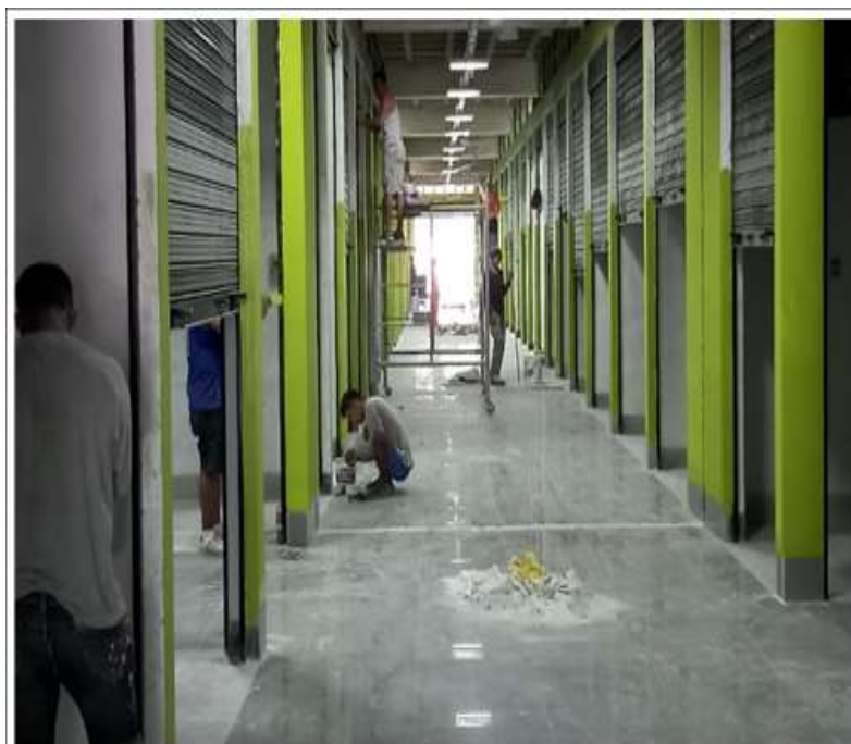
En la imagen se observa el proceso de pintado de muros.
