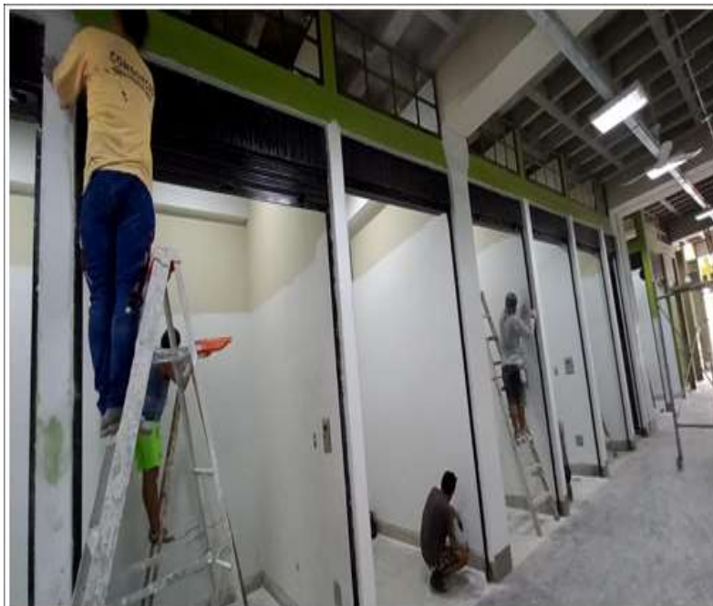
Se aprecia el proceso de empastado y lijado de superficie de muros de los puestos del segundo nivel del Mercado Tingo María.
