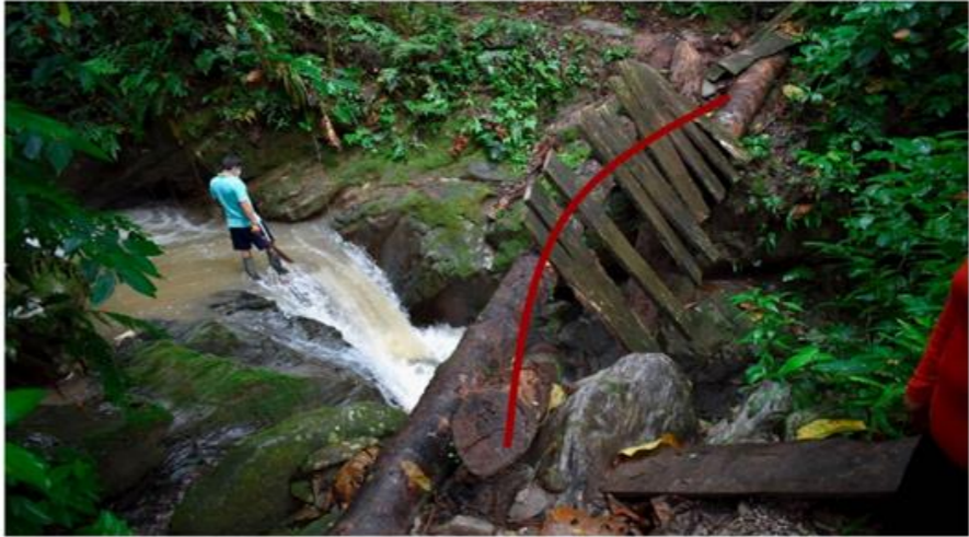
FOTO ESTADO ACTUAL
