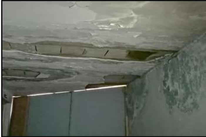
**Imagen:** Cielo raso en estado precario en los pasillos de la IPRESS La Unión
