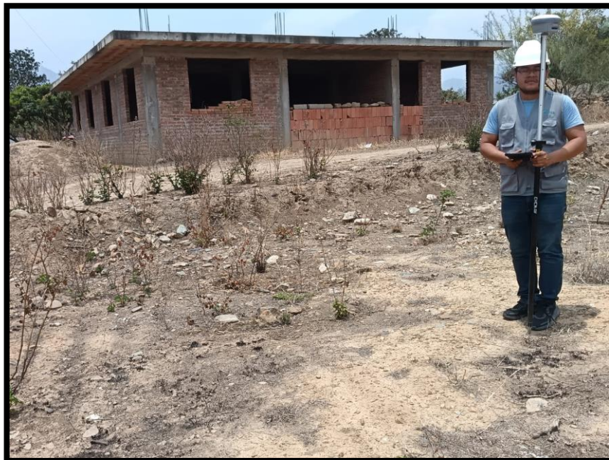
Realizando mediciones topográficas
