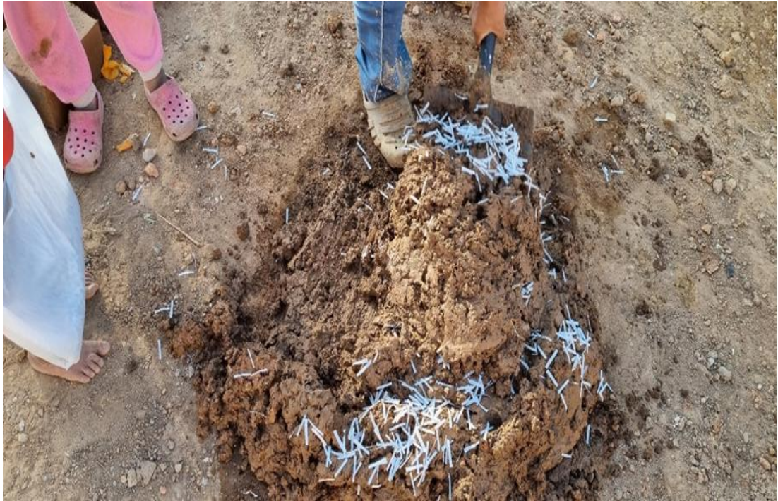
Fotografía. - Proceso de mezcla del barro para el adobe con la adición del polietileno de baja densidad
