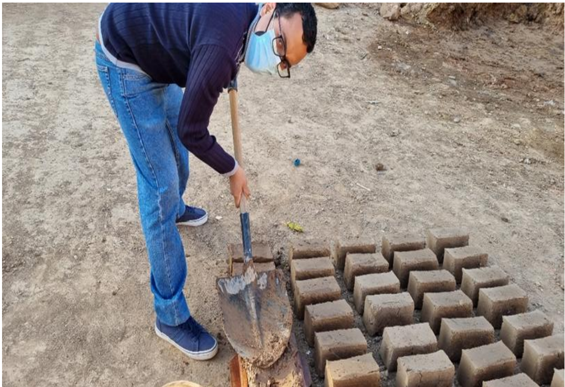
Fotografía. - Se le llena el molde de adobe con la mezcla de barro con polietileno de baja densidad
