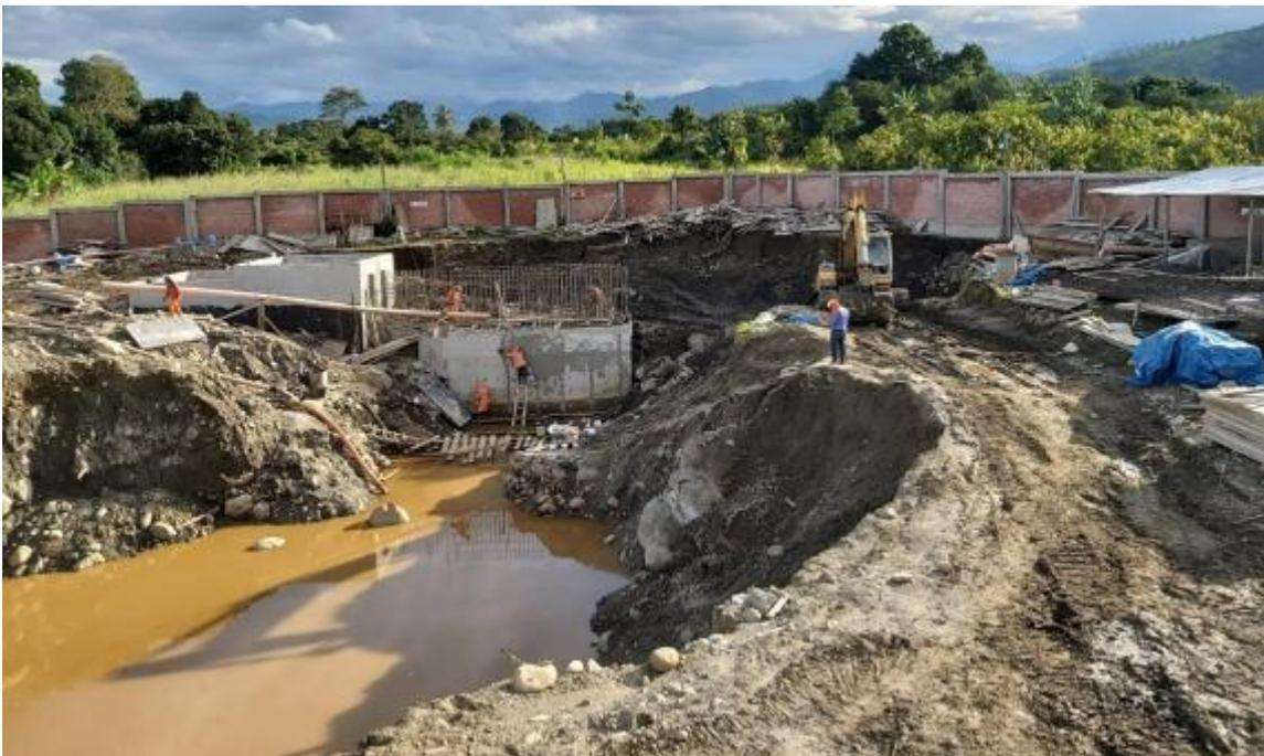
En la captura fotográfica se observa la verificación de los aceros estructurales y el encofrado del módulo de Pre-Tratamiento, así como la Excavación para el Tanque de Homogenización en la Planta de Tratamiento de Aguas Residuales (PTAR).
