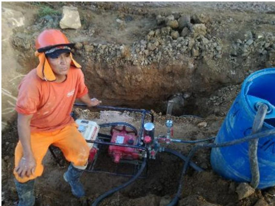
Vista del equipo para la realización de la prueba hidráulica en tuberías de líneas de aducción.
