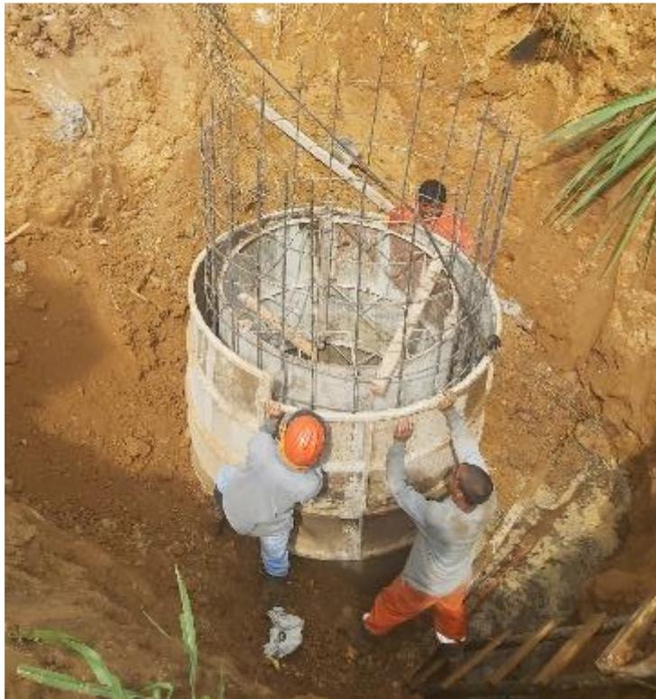
Encofrado de buzones de concreto armado  $F'c = 210K \text{ g/cm}^2$ ,  $\varnothing$  interior de 1.50, altura mayor a 3.00 m
