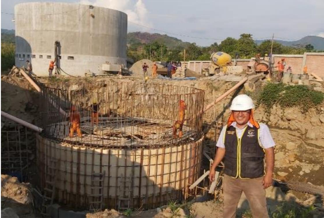
En la captura fotográfica se observa los trabajos de colocación de concreto en la pantalla de la Cámara de Aireación Flash en la Planta de Tratamiento de Aguas Residuales (PTAR).
