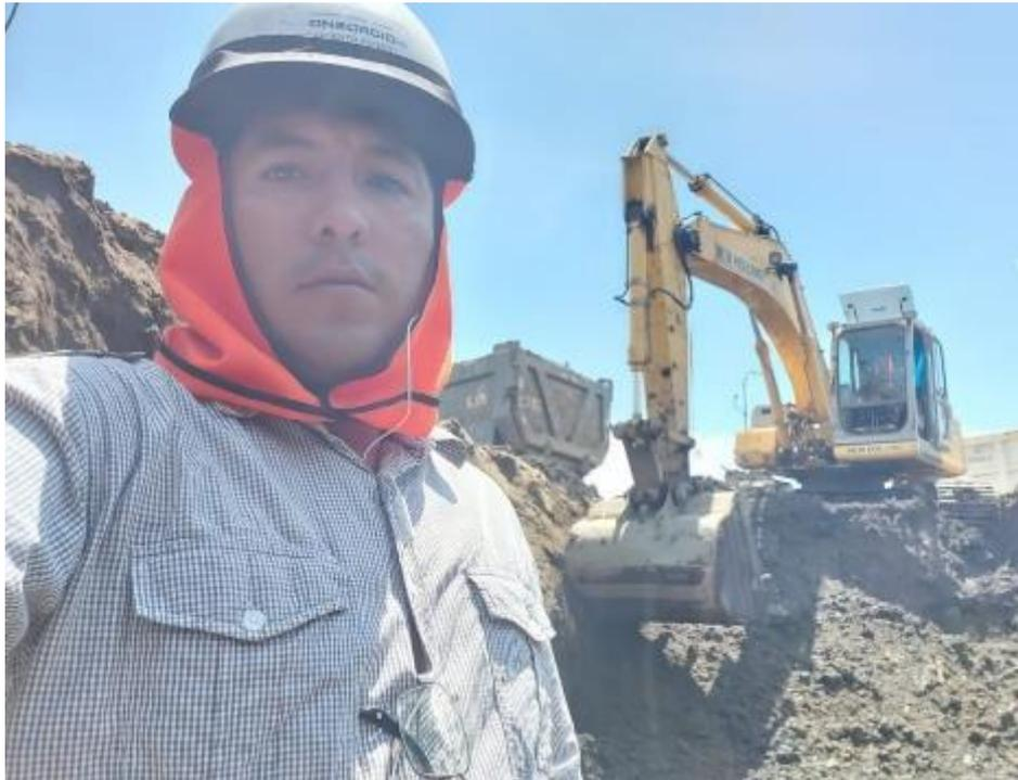
En la captura fotográfica se observa excavación para el Tanque de Homogenización en la Planta de Tratamiento de Aguas Residuales (PTAR).
