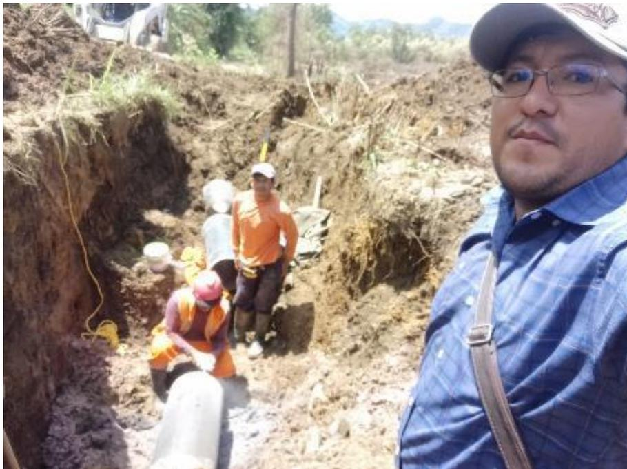
Vista de la Colocación de unión corrediza PVC de unión flexible Ø 315 mm
