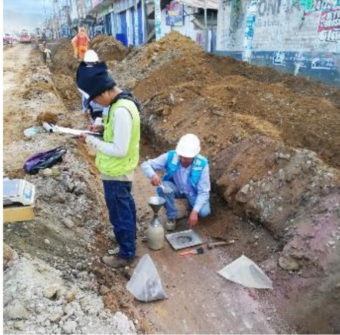
Pruebas de compactación en zanjas para agua potable.
