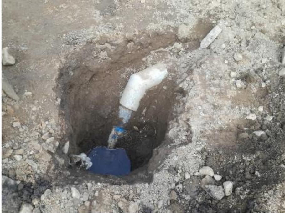
Vista de Tubería de 2" de diámetro de agua potable existente, ubicada a 0.30 m aproximadamente.
