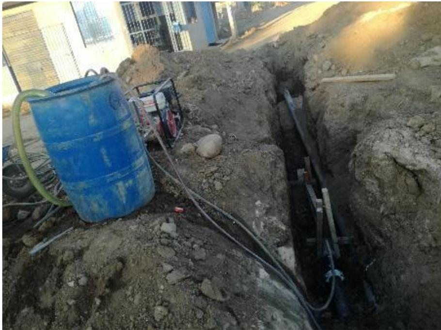
Vista de la realización de la prueba hidráulica en tuberías de agua potable.
