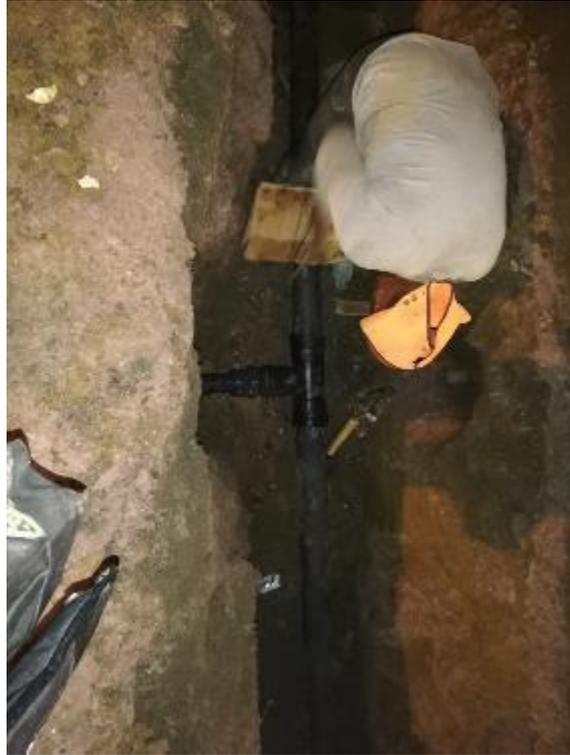
Instalación de tuberías y accesorios de agua potable, en la vista se aprecia la instalación de tubería PVC UF de 90 mm, una Té de 90 mm x 90 mm y la instalación de una reducción de 90mm a 63 mm.
