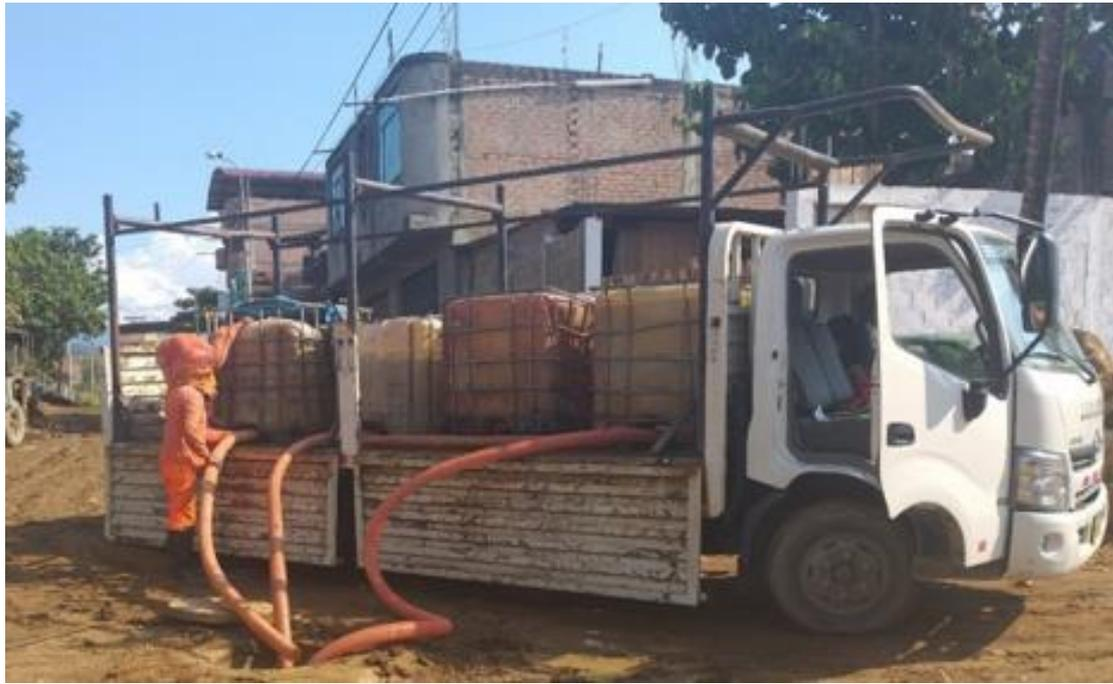
Llenado de buzones y tuberías de alcantarillado para prueba de estanqueidad.
