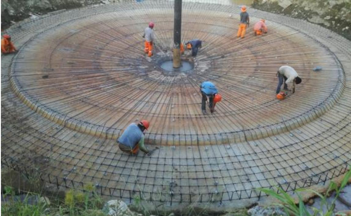
En la captura fotográfica se observa los trabajos de colocación de acero estructural en zapatas para la Cámara de Aireación Flash en la Planta de Tratamiento de Aguas Residuales (PTAR).
