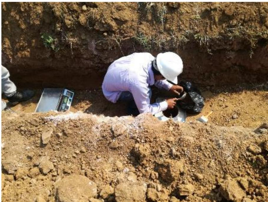
Vista de realización de prueba de compactación en redes de alcantarillado.
