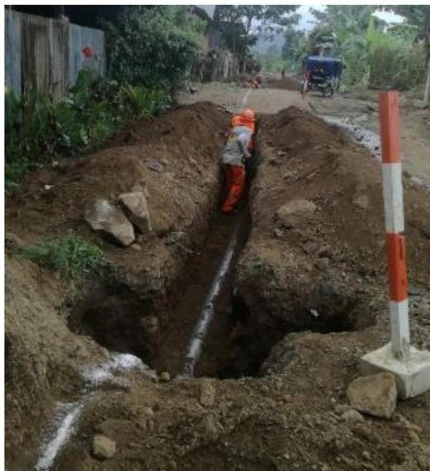
Vista de Tubería de 6" de diámetro de agua potable existente, ubicada a 0.60 m.
