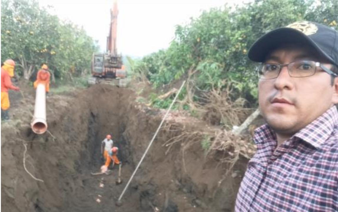
En la captura fotográfica se observa los trabajos de excavación y tendido de tuberías para la red de alcantarillado sanitario.
