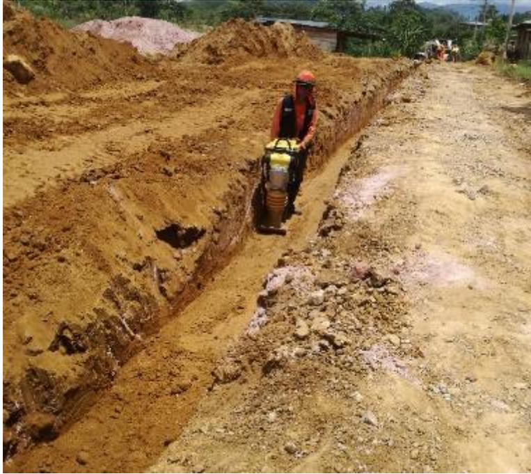
Segundo relleno y compactación de zanjas de alcantarillado
