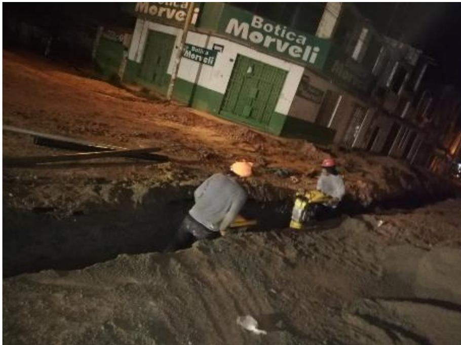
Vista del compactado en segundo relleno en zanjas de línea de aducción.
