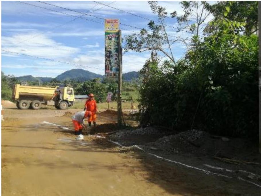
VISTA DE LA REALIZACIÓN DE PIQUES PARA UBICACIÓN DE TUBERÍA EXISTENTE.
