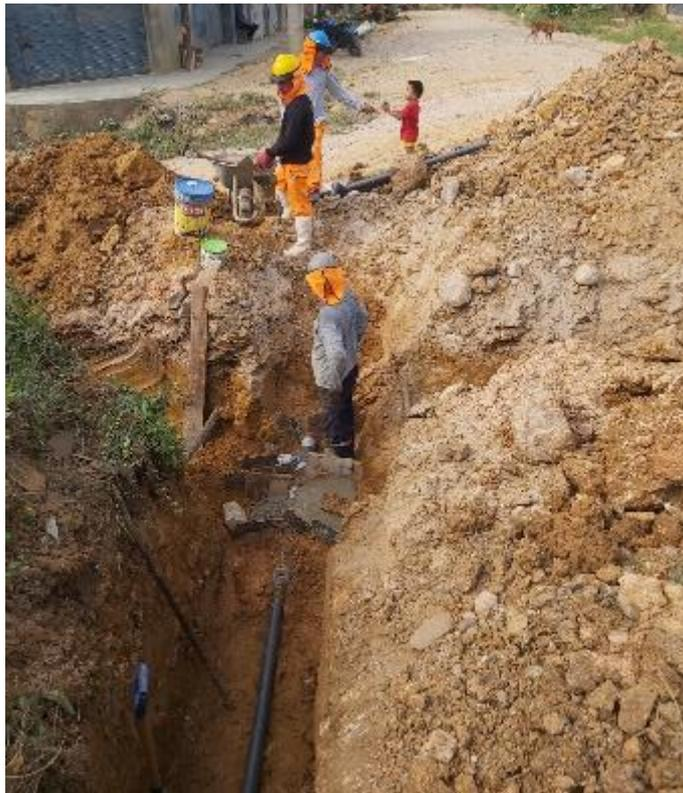
Vista de la construcción de dados de anclaje en los accesorios de tubería de agua potable.
