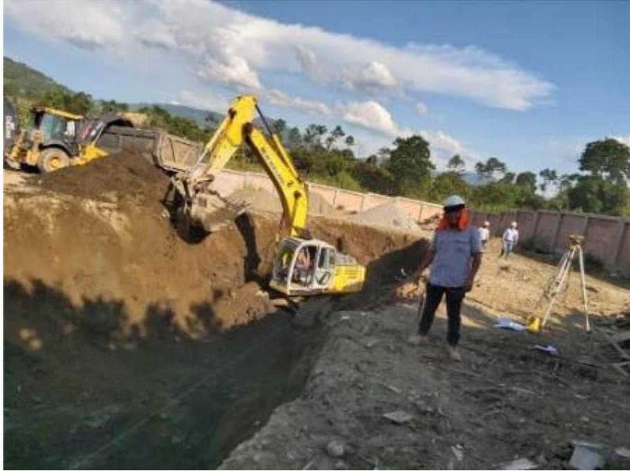
En la captura fotográfica de la excavación y nivelación de cotas topográficas para el módulo de Pre-Tratamiento.
