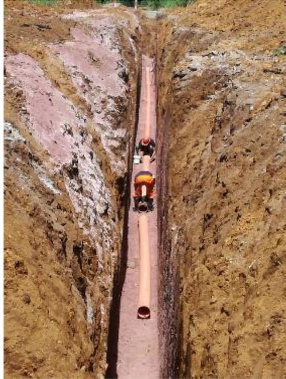
Colocación de tubería PVC unión flexible Ø 200 mm en redes de alcantarillado
