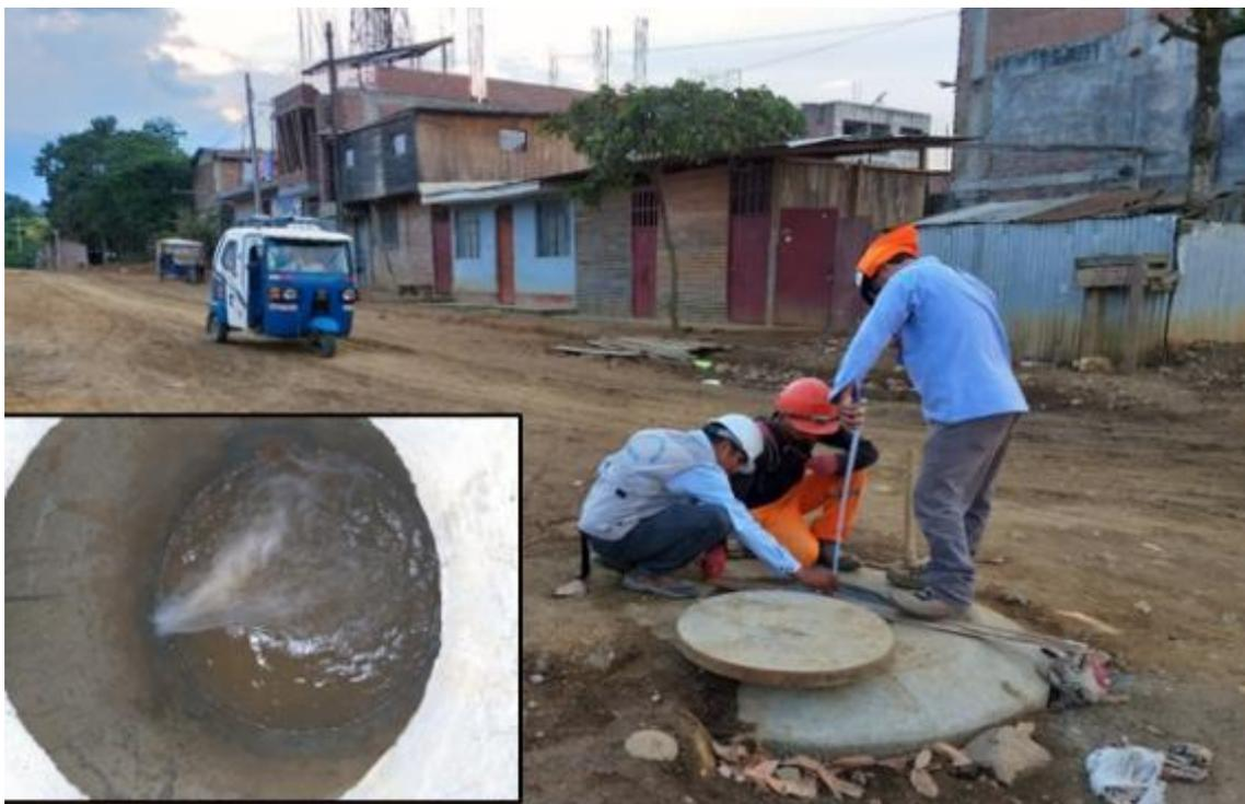
Realización de la prueba de estanqueidad y rotura de tapones.
