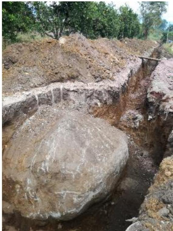
Vista de la presencia de roca fija en la línea de red de alcantarillado
