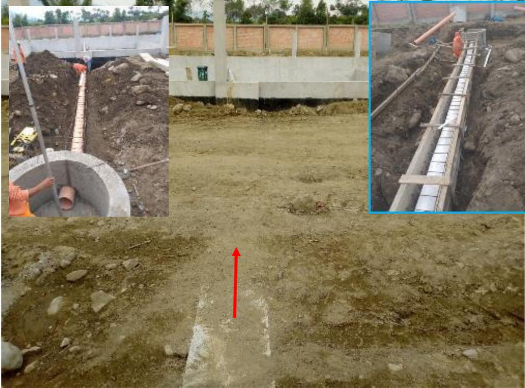
Vista de la instalación de la red de colector de alcantarillado con ingreso al lecho de secado.
