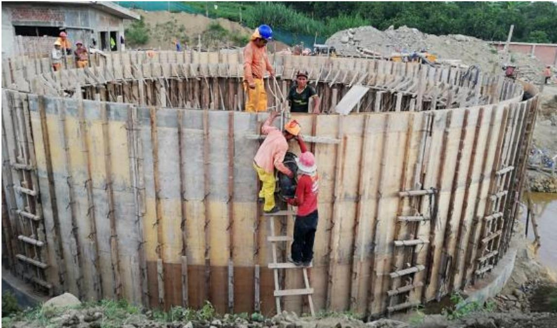
En la captura fotográfica se observa los trabajos de encofrados de la Cámara de Aireación Flash en la Planta de Tratamiento de Aguas Residuales (PTAR).
