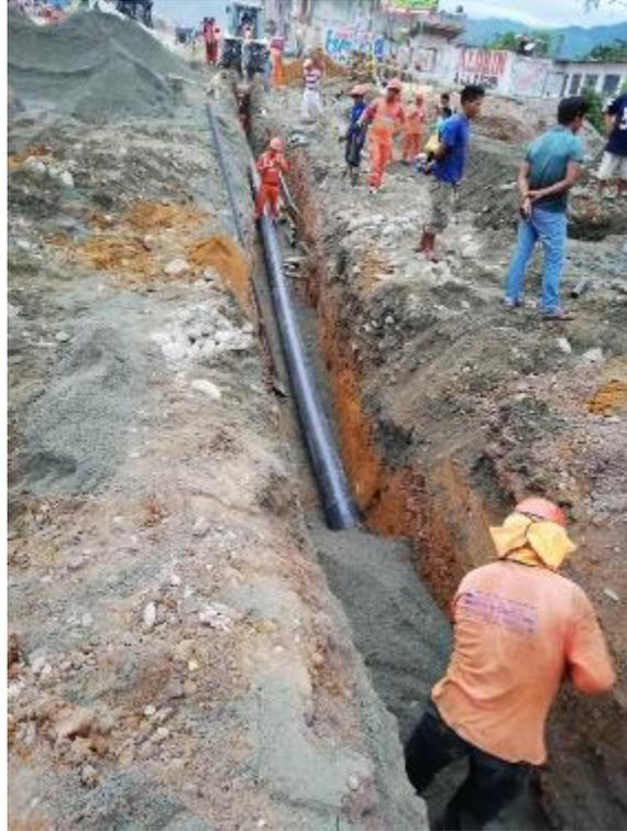
Vista de la Colocación del primer relleno en tubería Ø 250 mm en línea de aducción.
