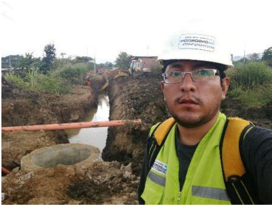
Vista de la excavación de zanjas en zonas saturadas, para redes de alcantarillado
