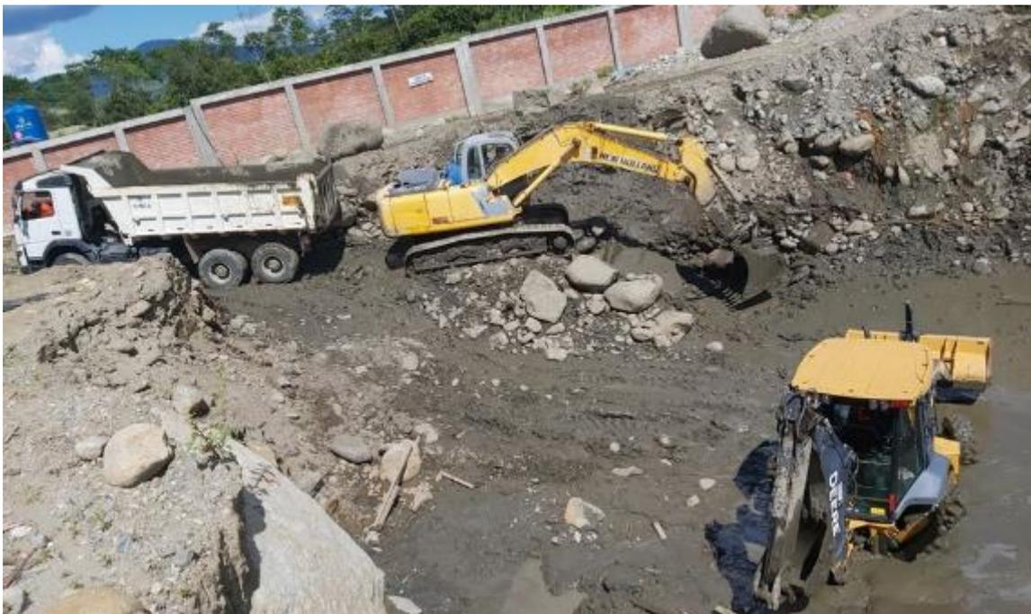
En la captura fotográfica se observa la excavación para el módulo de tanque de Homogenización en la Planta de Tratamiento de Aguas Residuales (PTAR).
