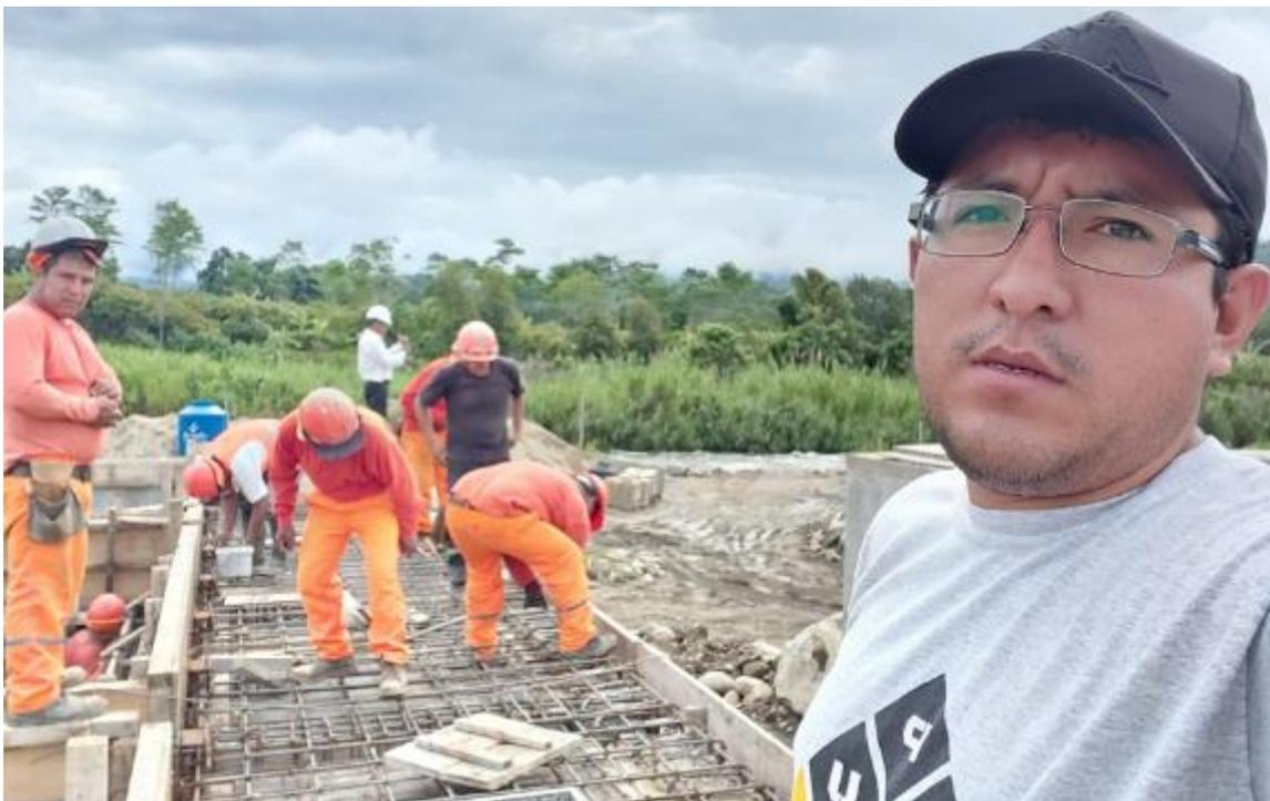
En la vista fotográfica se observa los trabajos encofrados y su colocación de acero estructural en el módulo del Reactor Anaeróbico de Flujo Ascendente (RAFA) en la Planta de Tratamiento de Aguas Residuales (PTAR).
