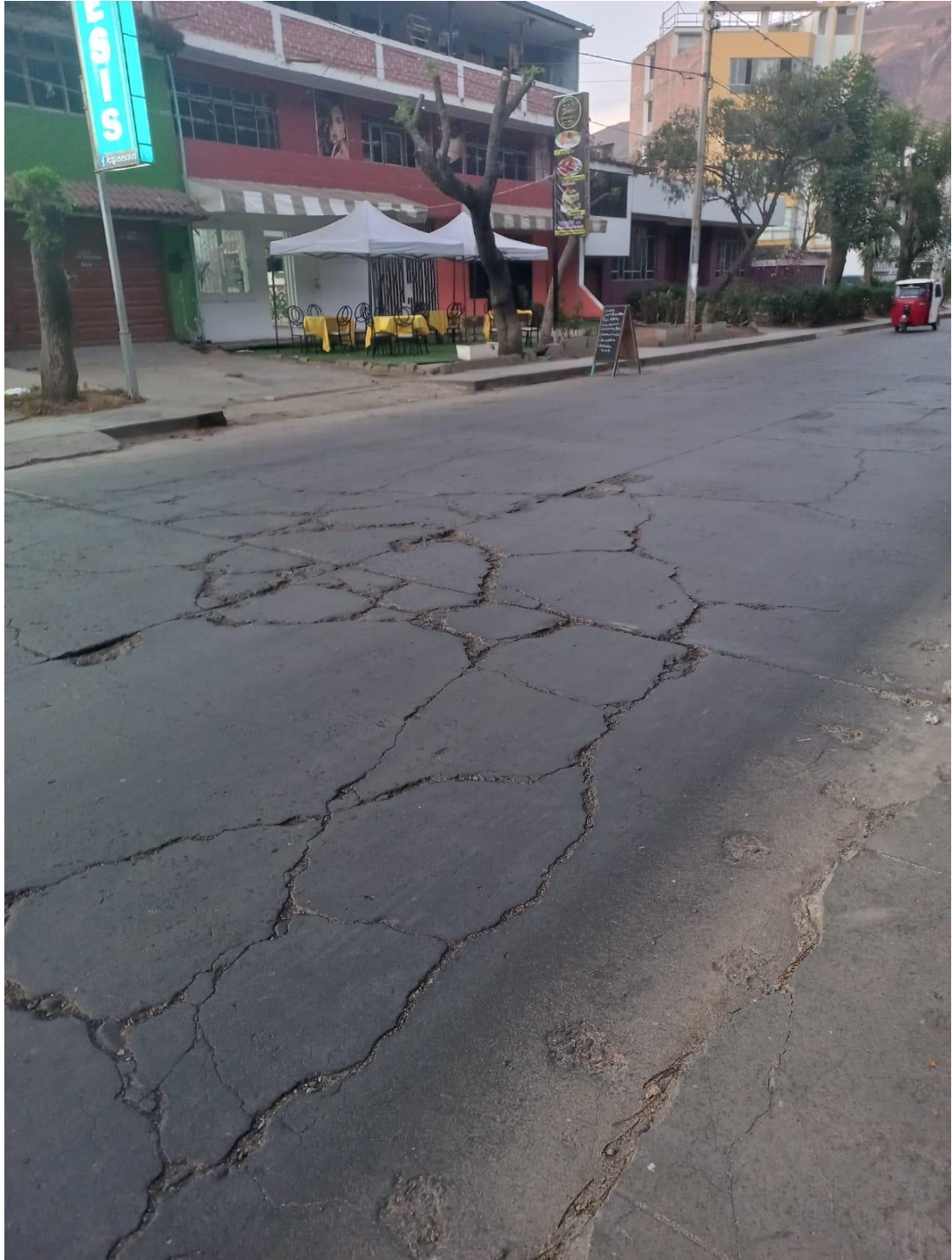
Pavimento colapsado
