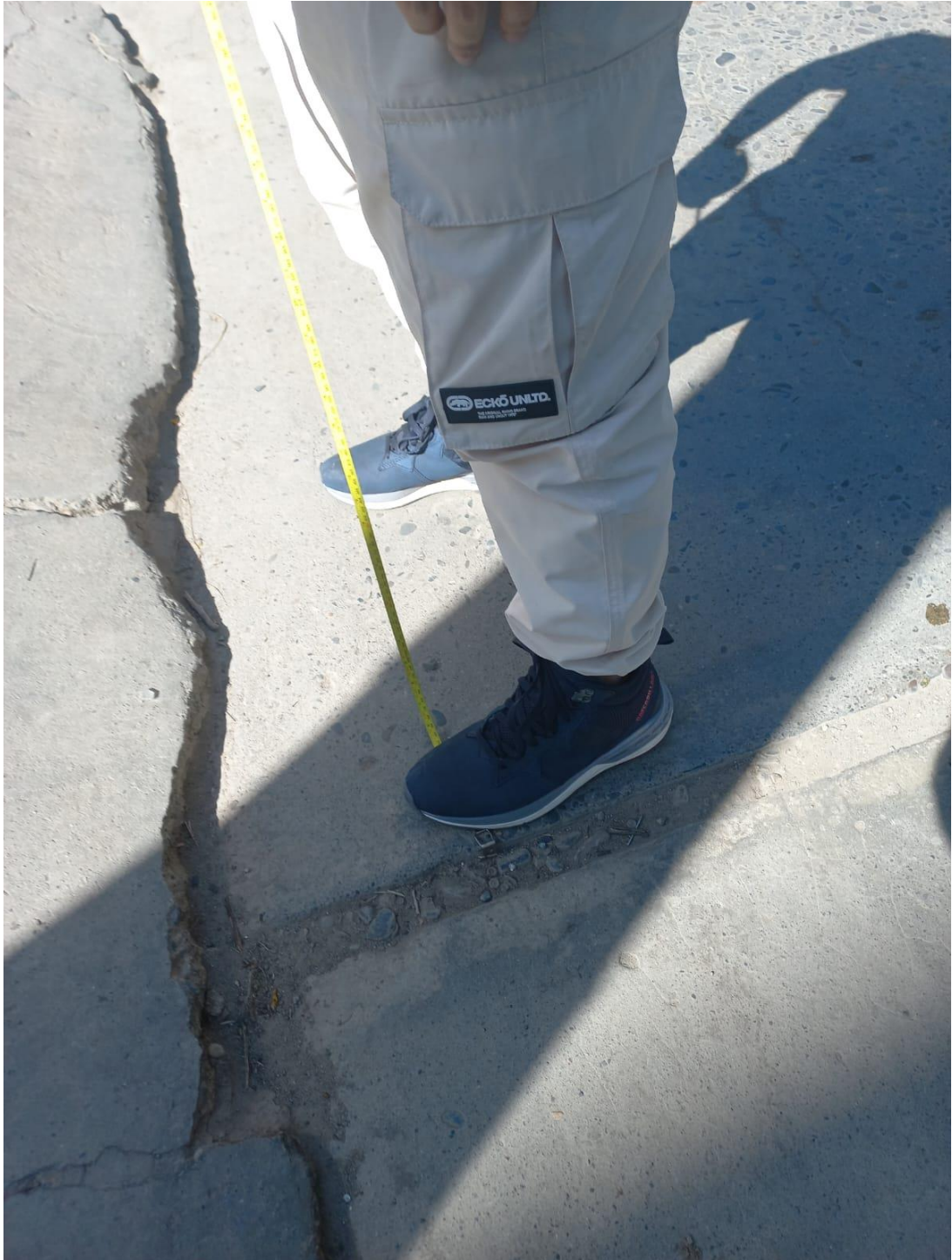
Ubicación del inicio de la losa
