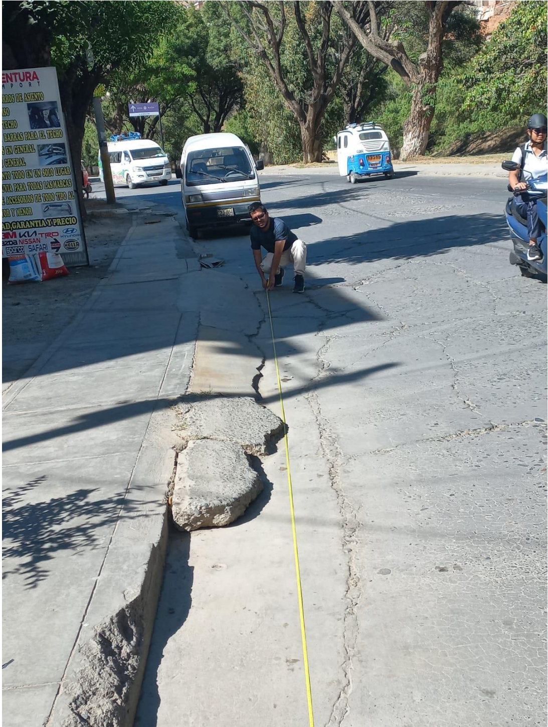
Medición del largo de una losa de concreto
