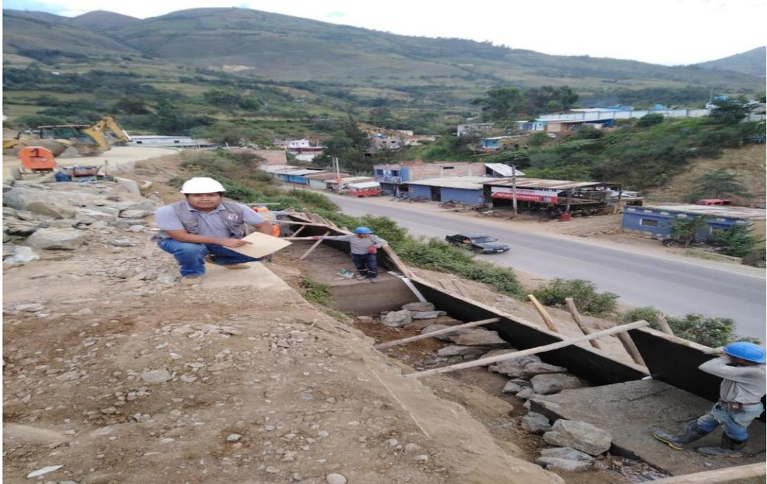
*Nota.* Se realiza la construcción del muro de contención para la posterior ejecución de las pistas y veredas.
