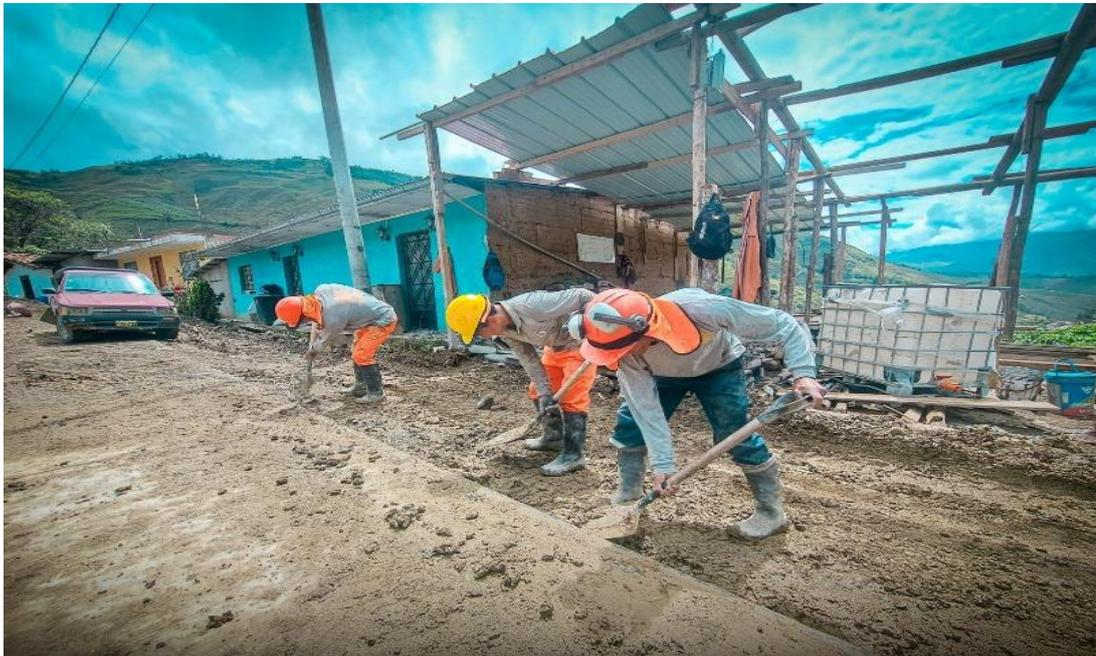
*Nota.* Se realiza la limpieza del material excedente para la construcción de las veredas.
