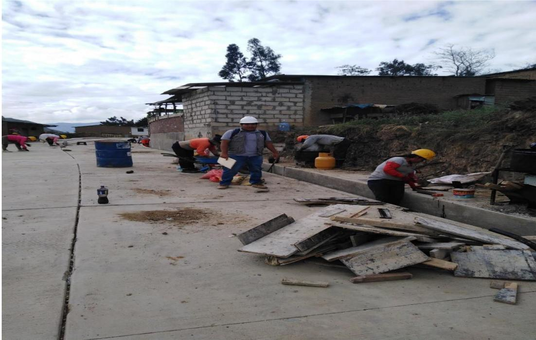
*Nota.* Se realiza la verificación del retiro del encofrado en las veredas.
