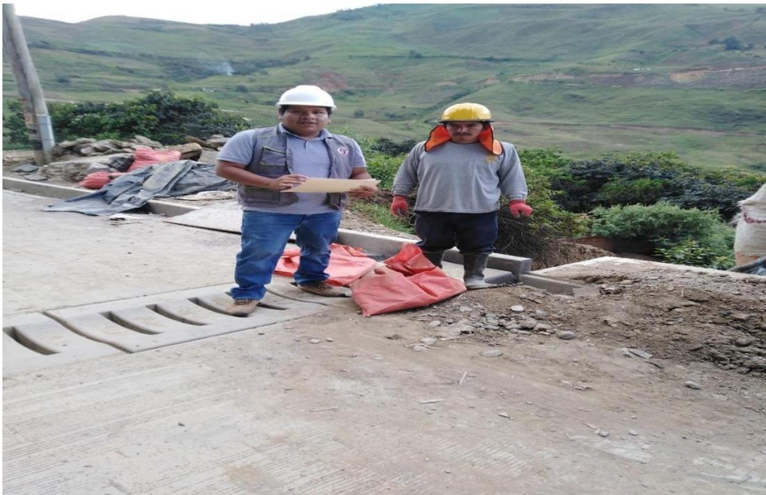
*Nota.* Se verifica el acabado de los drenajes pluviales con el fin de asegurar la circulación adecuada del agua.
