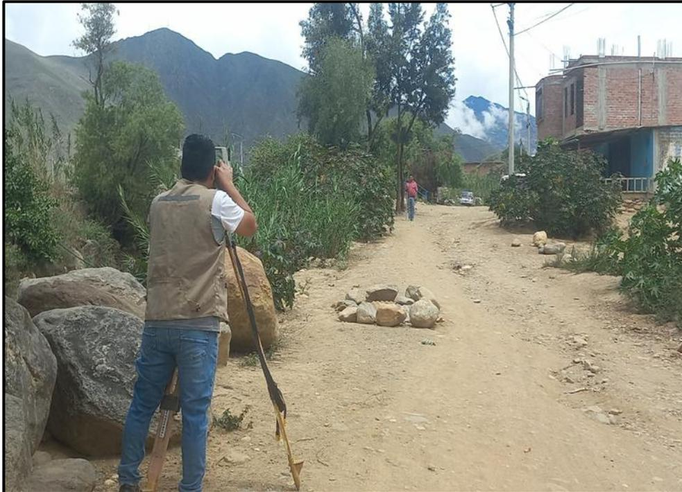
*Nota.* Se ve el levantamiento topográfico de la quebrada Jancao KM 00+800.
