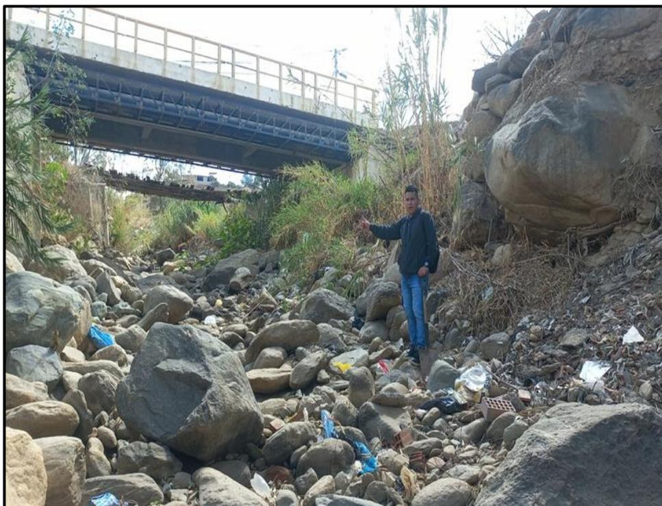
*Nota.* Se aprecia a la altura del puente peatonal de Jancao alto, una acumulación de material solido de gran tamaño.
