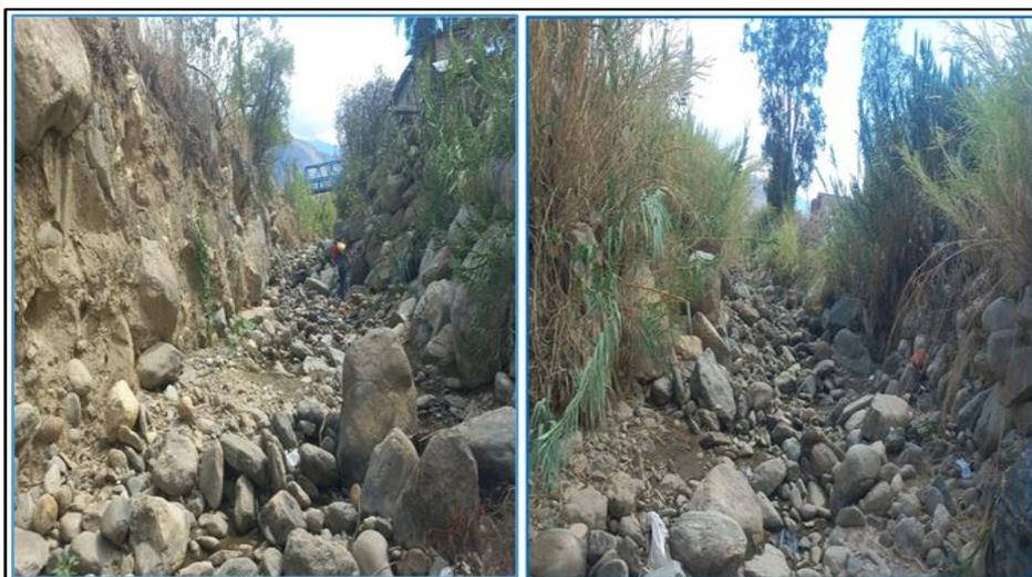
*Nota.* Se observa los Taludes ligeramente erosionados y el cauce ligeramente socavado, dando una irregularidad de tipo menor.
