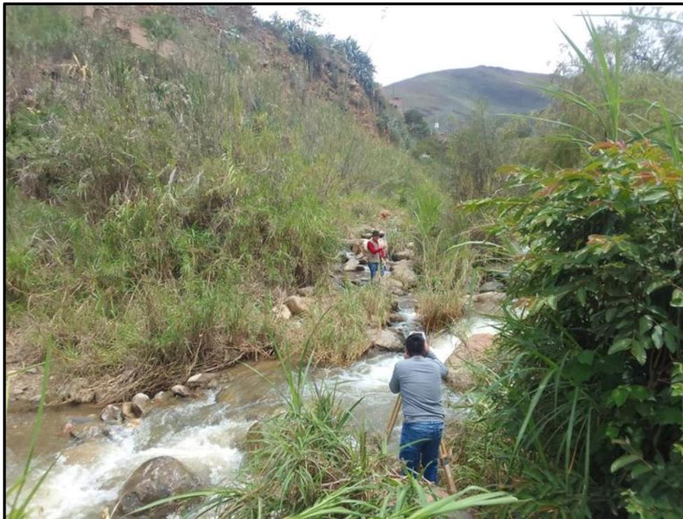
*Nota.* Se ve el levantamiento topográfico de la quebrada Jancao KM 02+000.
