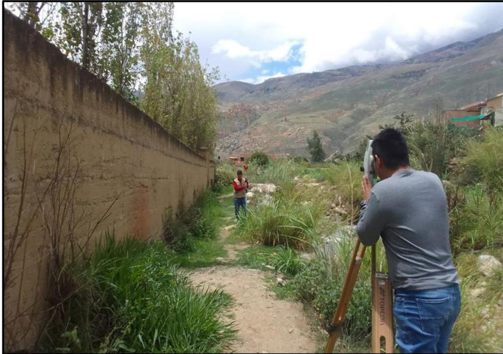
*Nota.* Se ve el levantamiento topográfico de la quebrada Jancao KM 01+000.
