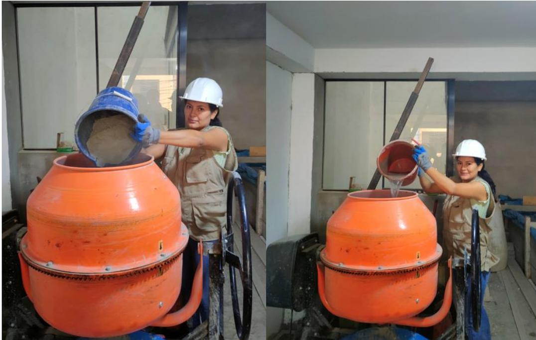
*Nota.* Proceso de elaboración de la mezcla de concreto con  $F'c= 210 \text{ kg/cm}^2$  como lo indica la normativa ACI 211, adición del cemento junto con el agua.
