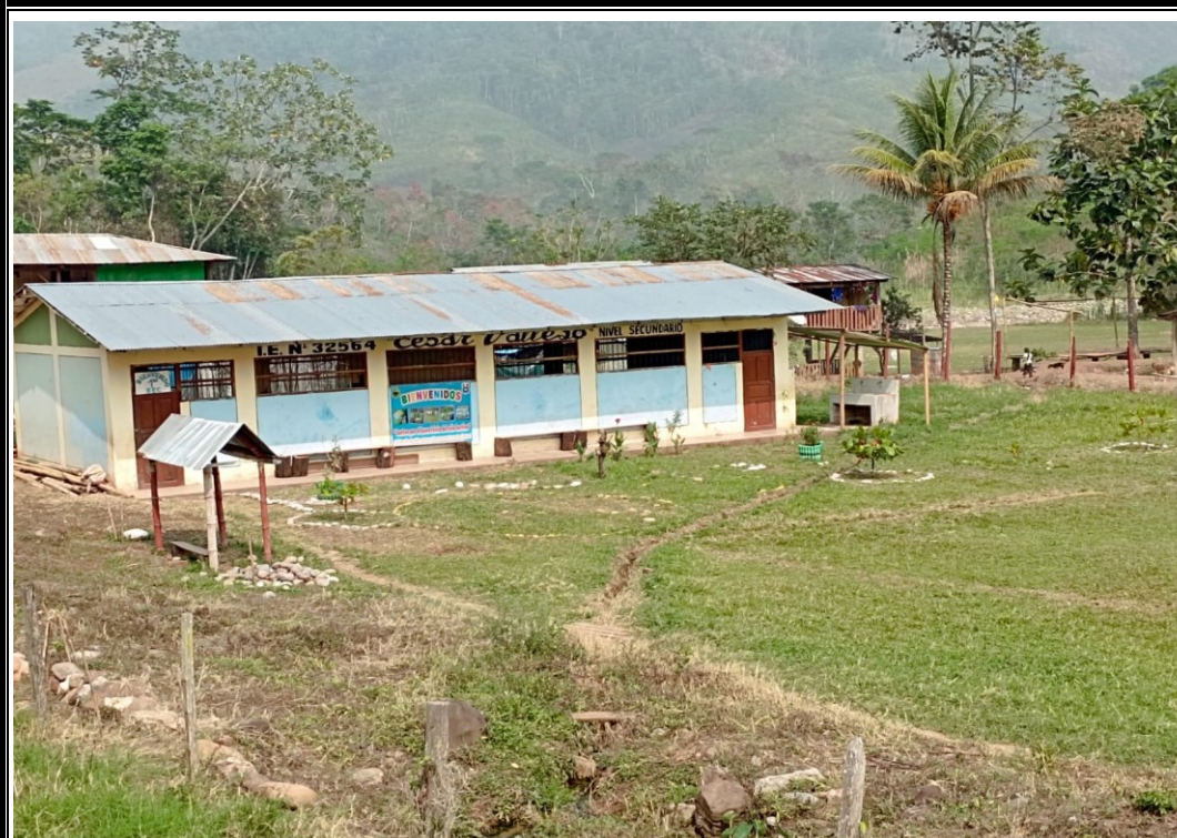
SE OBSERVA LA I.E. N°32564 – CESAR VALLEJO-NIVEL SECUNDARIO.
