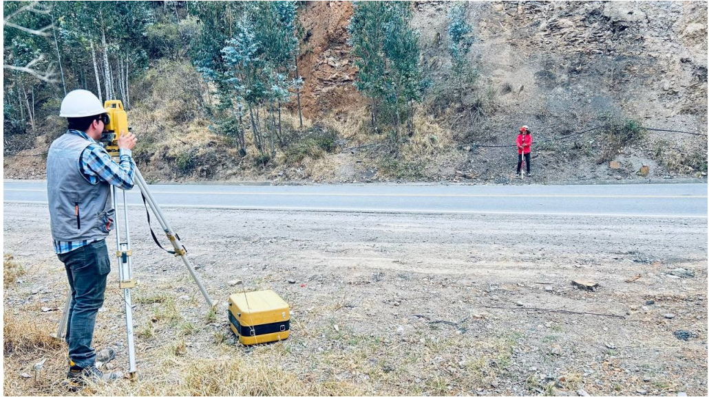
Continuación de toma de puntos, carretera margen derecha
