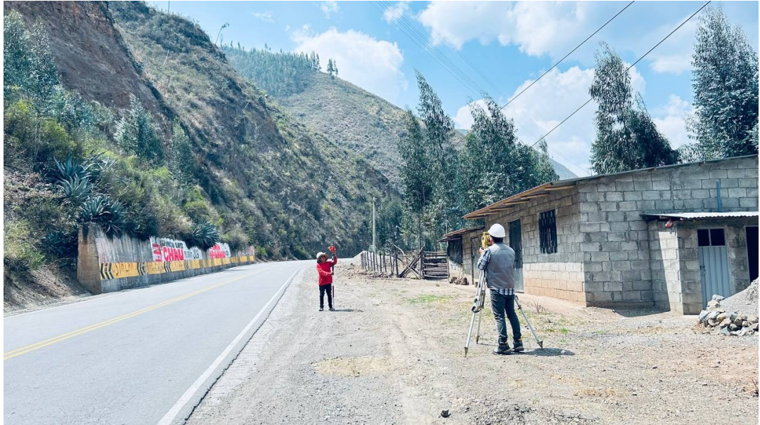
Continuación de toma de puntos, carretera margen izquierda
