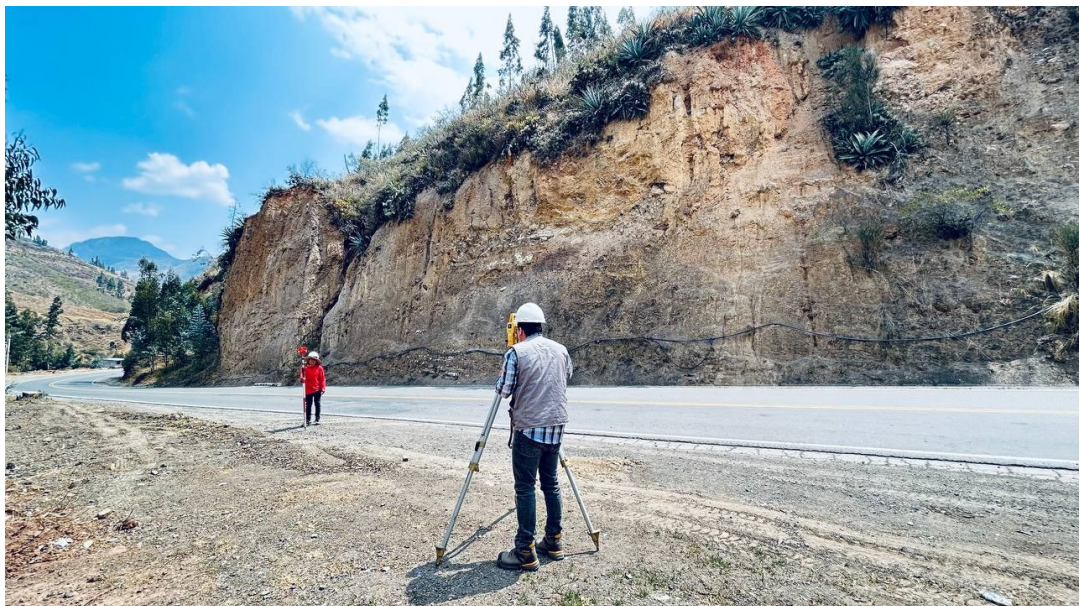
Culminación del levantamiento topográfico
