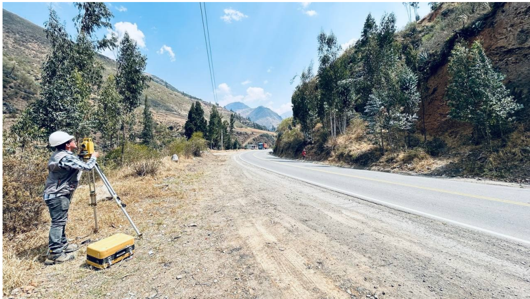
Continuación de toma de puntos, carretera margen derecha
