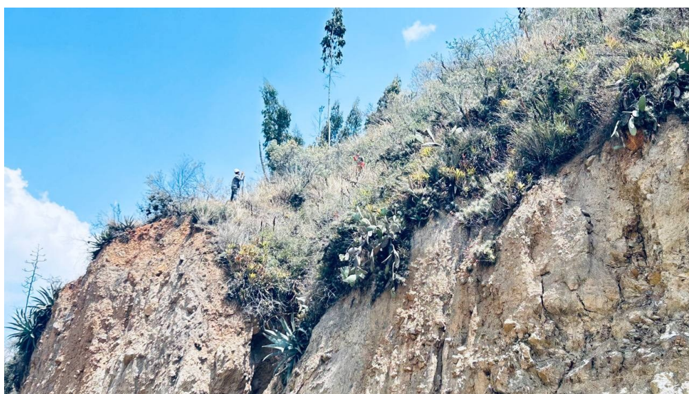
Vista desde la carretera hacia el talud del levantamiento topográfico
