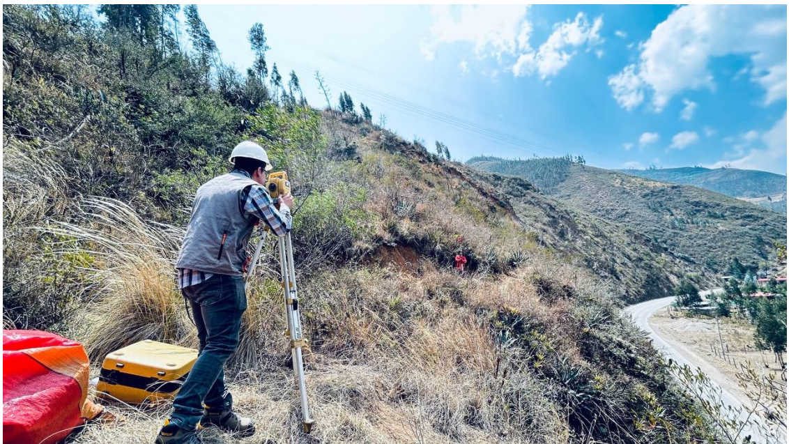
Continuación de toma de puntos, talud
