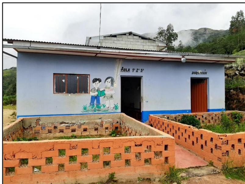
Módulo 03, el módulo consta de un nivel con los ambientes de servicios higiénicos de varones y mujeres, con muros de ladrillo King Kong no convencional con ancho de 12 cm. no cuenta con vigas ni columnas, techo de calaminas a dos aguas con listones de madera, cielorraso de triplay, piso de cemento pulido, puertas metálicas con ventanas de sistemas nova.
