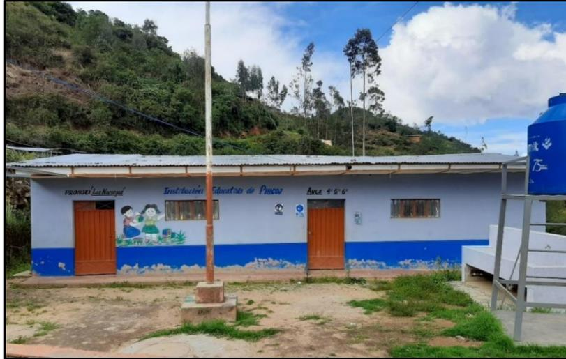
Módulo 05, el módulo consta de dos niveles, conteniendo en el primer nivel el ambiente de: depósito general. En el segundo nivel contiene los siguientes ambientes: cocina y comedor, con muros de tapial con ancho de 40 cm, sin contar con vigas ni columnas, techo de calaminas a dos aguas con tijerales de madera con cielorraso de triplay y el piso de terreno natural nivelado en primer nivel, piso de entablado en el segundo nivel, puertas y ventanas de perfiles metálicos.
