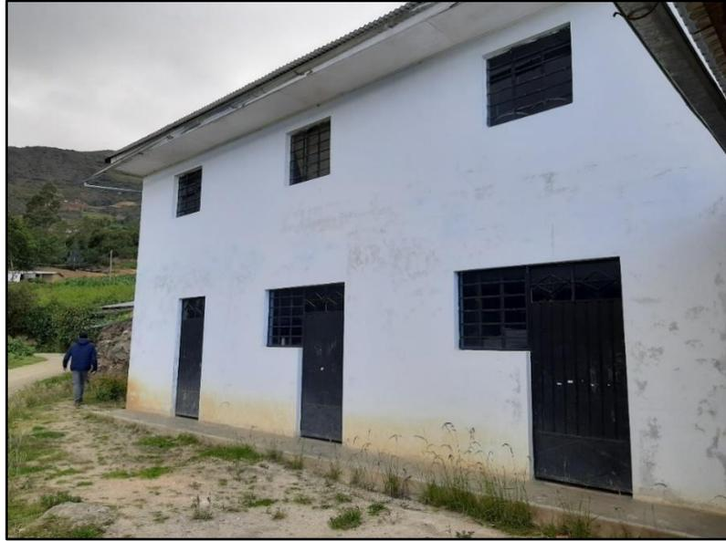
Módulo 02, el módulo consta de un nivel, conteniendo los ambientes de: aulas de 1ro, 2do y 3er grado y dirección, con muros de adobe con ancho de 23 cm, sin contar con vigas y columnas, techo de calamina con listones de madera a dos aguas con cielorraso de triplay, piso de cemento pulido, puertas y ventanas de perfiles metálicos.
