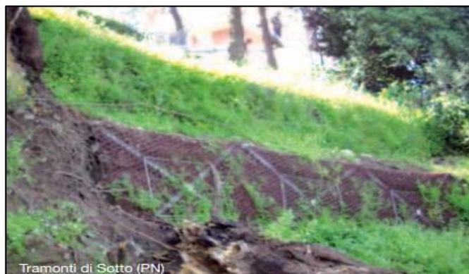
*Nota.* La figura muestra el tipo de Erdox Junior normal en una estabilización de un talud.
