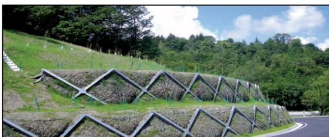
*Nota.* La figura muestra el tipo de Erdox para tierra en una estabilización de un talud.
