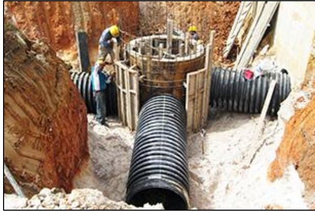
*Nota.* Sistema de tuberías corrugadas de polietileno de alta densidad, de 18" a 60" de diámetro interior, para colectores y descargas en sistemas de alcantarillado público. (Henares, 2020)
