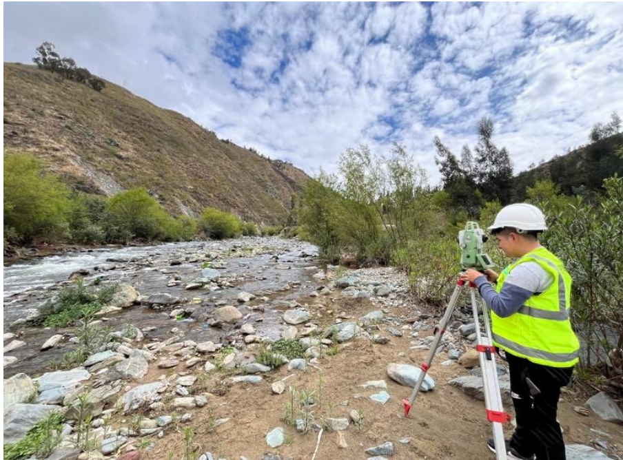
Fotografía: Se visualiza el levantamiento topográfico de la cuenca donde se realizó el estudio de trabajo.
