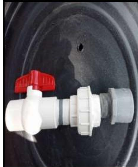
Modelo de instalación: Cinta teflón, llave de paso  $\frac{3}{4}$ " pvc Pavco, niples pvc de  $\frac{3}{4}$ " a 1", unión universal pvc  $\frac{1}{2}$ " (agua fria), adaptadores pvc  $\frac{1}{2}$ ", huacha de metal, jebe de llanta de carro y tijera
