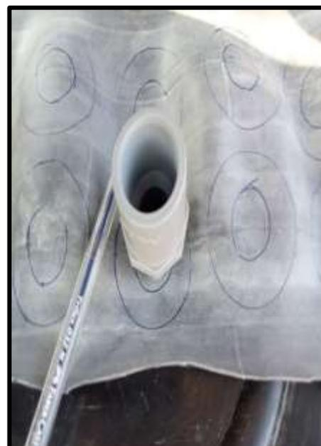
Colocación de adaptadores pvc  $\frac{1}{2}$ " en el bidón de biodigestor envuelta con la cinta teflón
