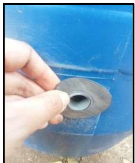
Uso de huacha de metal en conjunto con la huacha de jebe, se coloca atrás y delante de los adaptadores pvc 1/2" envuelta con cinta teflón
