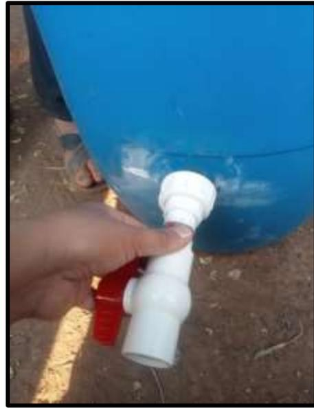
Encima del adaptador pvc  $\frac{1}{2}$ " enroscar la unión universal pvc  $\frac{1}{2}$ " (agua fria), luego se procede a colocar los nipples pvc de  $\frac{3}{4}$ " a 1" envuelto de cinta teflón, para finalmente enroscar la llave de paso  $\frac{3}{4}$ " pvc Pavco. Posterior a ello, realizar la prueba de la permeabilidad para comprobar que no hay fuga de líquidos.
