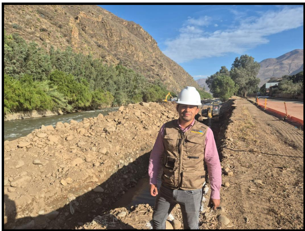
FOTOGRAFÍA N°04: EXCAVACIÓN EN ZONA DE MURO CICLÓPEO
