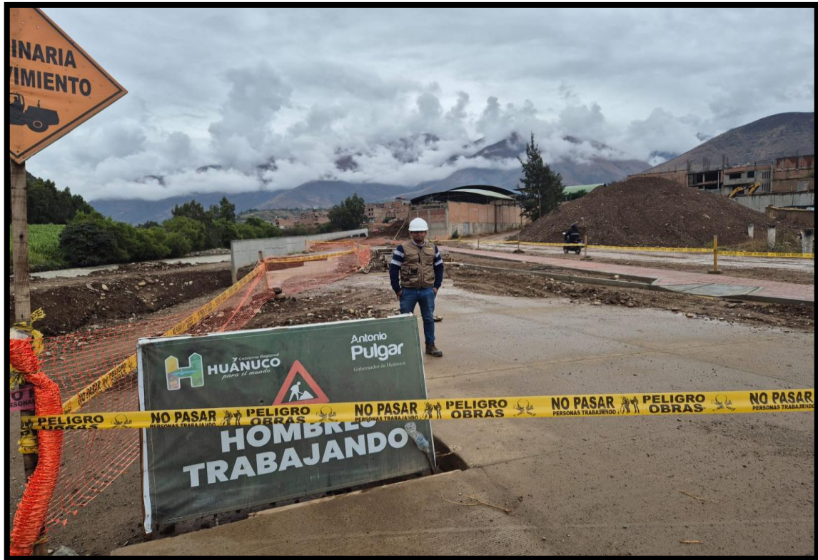
FOTOGRAFÍA N°11: CONTROL DE SEÑALIZACIÓN DE LOS TRABAJOS DE OBRA
