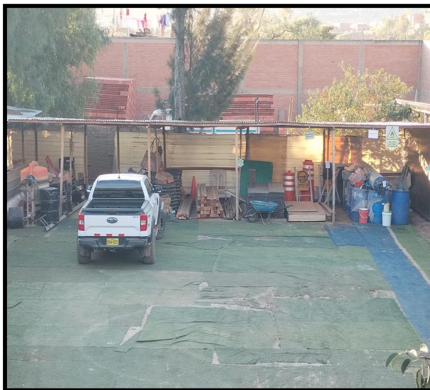
FOTOGRAFÍA N°22: MATERIALES DE CAMPAMENTO DE OBRA
