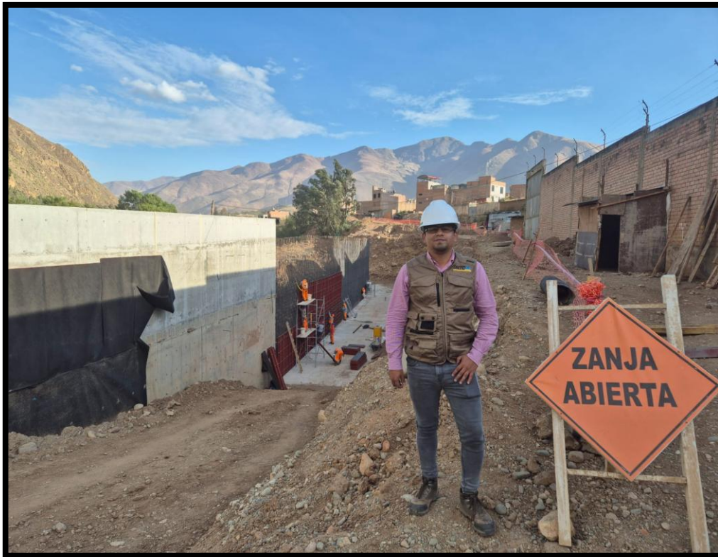
FOTOGRAFÍA N°05: CONTROL DE SEÑALIZACIÓN EN MURO DE CONCRETO ARMADO
