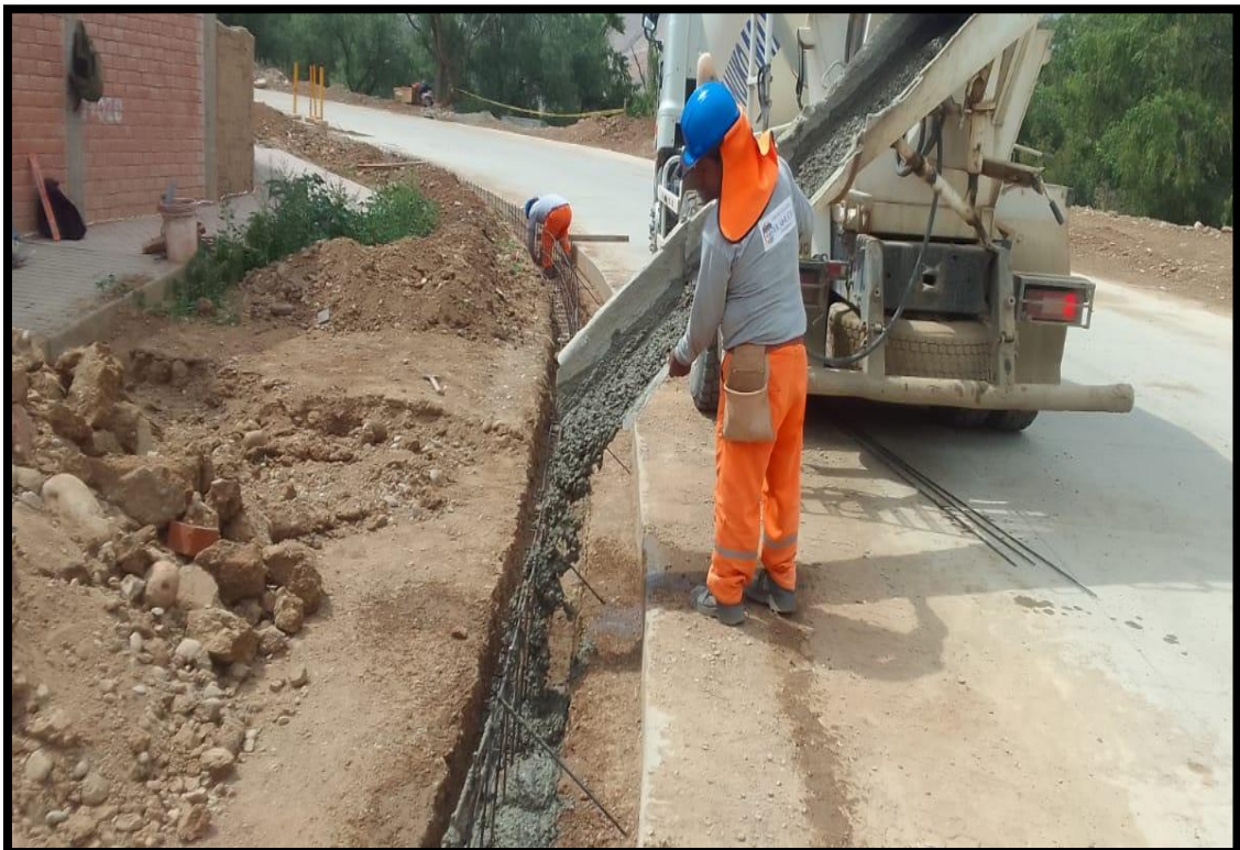
FOTOGRAFÍA N°12: CONTROL DE COLOCACIÓN DEL CONCRETO EN CIMIENTO DE SARDINEL
