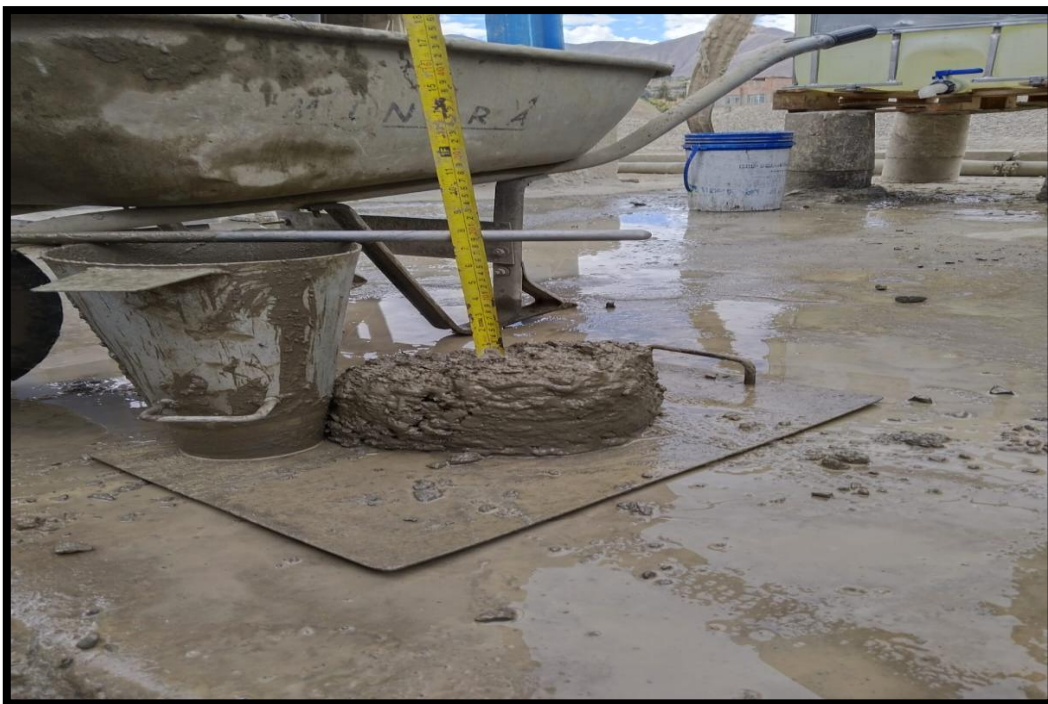
FOTOGRAFÍA N°14: CONTROL DE CALIDAD DE LA TRABAJABILIDAD DEL CONCRETO
