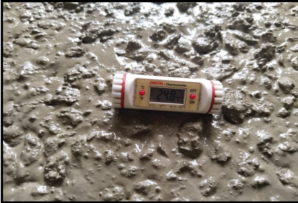
FOTOGRAFÍA N°13: CONTROL DE CALIDAD DE LA TEMPERATURA DEL CONCRETO
