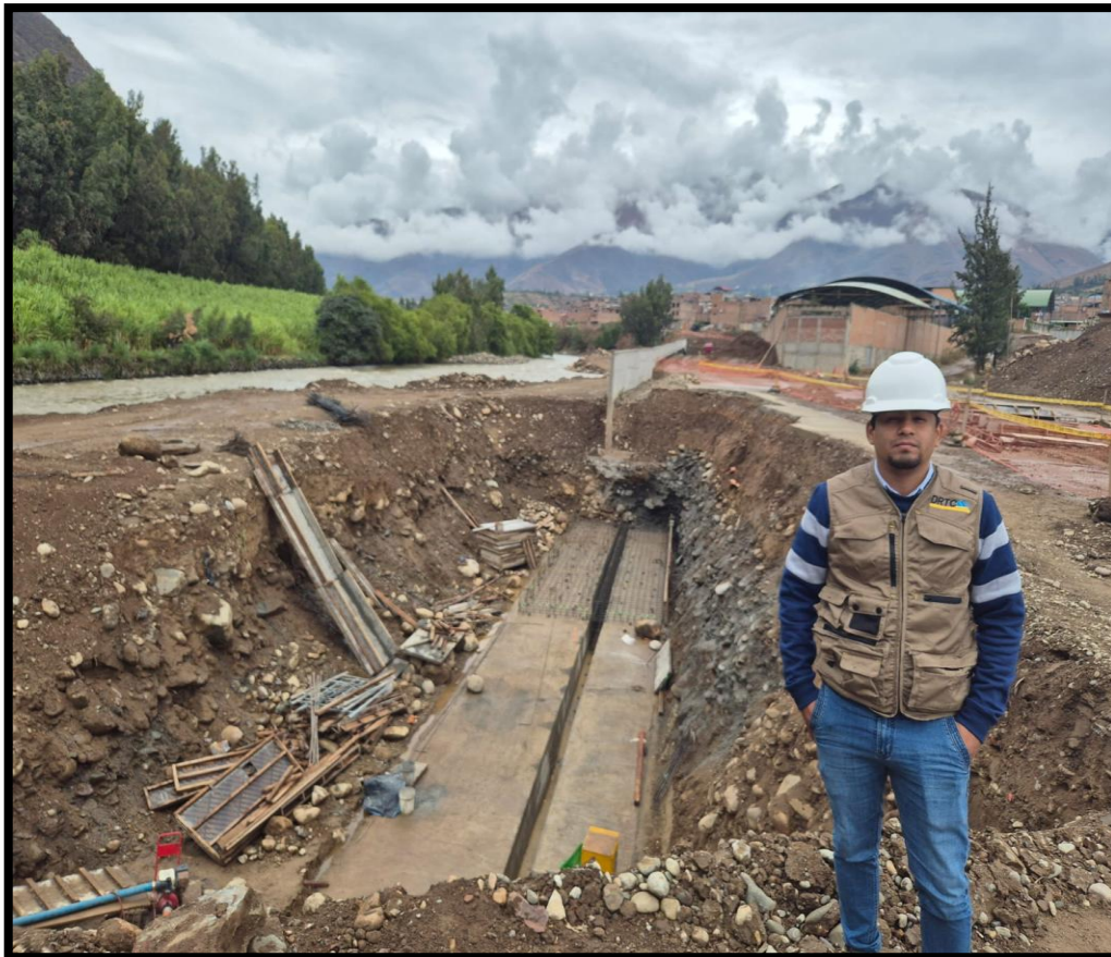
FOTOGRAFÍA N°10: CONTROL DE COLOCACIÓN DE ACERO EN PARRILLA DE ZAPATA
