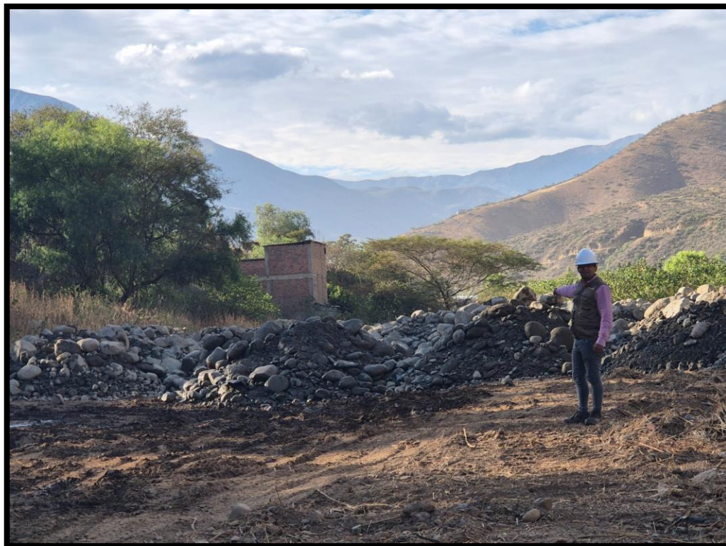
FOTOGRAFÍA N°03: ACOPIO DE MATERIAL DE RÍO
