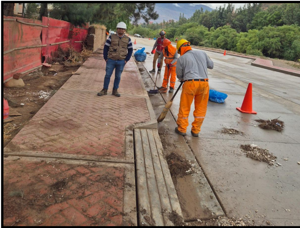
FOTOGRAFÍA N°09: CONTROL DE COLOCACIÓN Y ACABADOS DEL CONCRETO EN PAVIMENTOS
