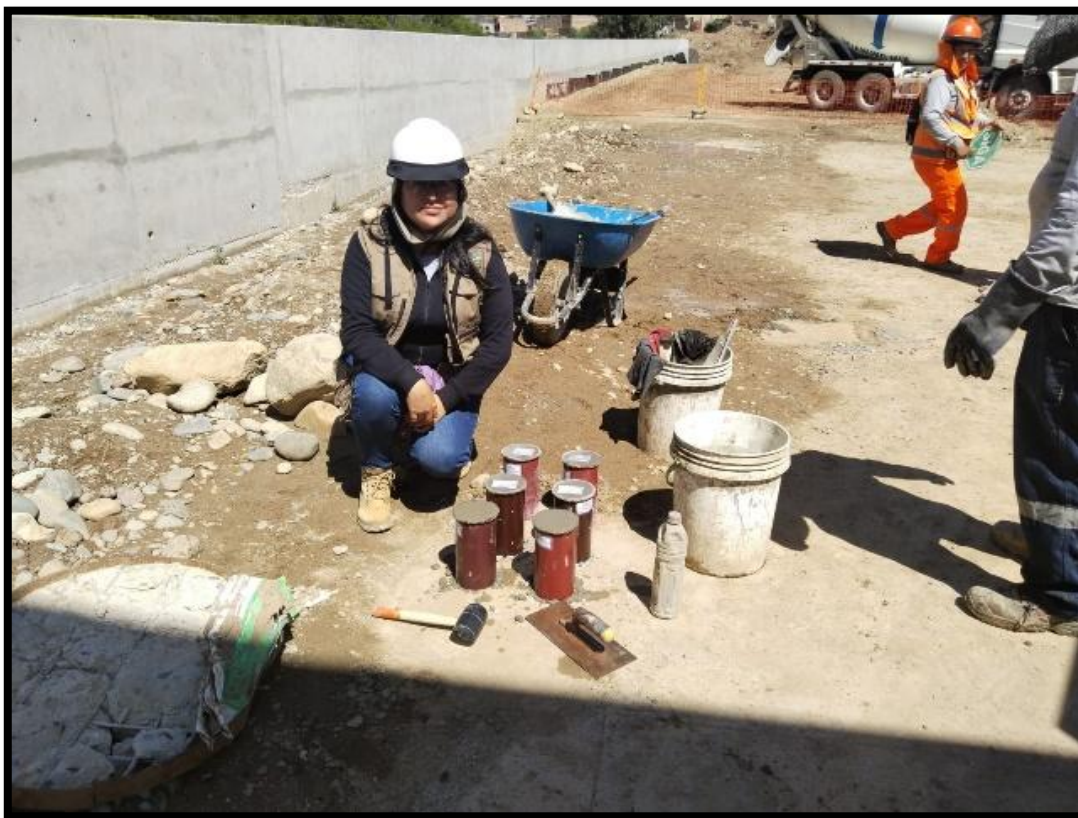
FOTOGRAFÍA N°17: TOMA DE MUESTRAS DE CONCRETO FRESCO
