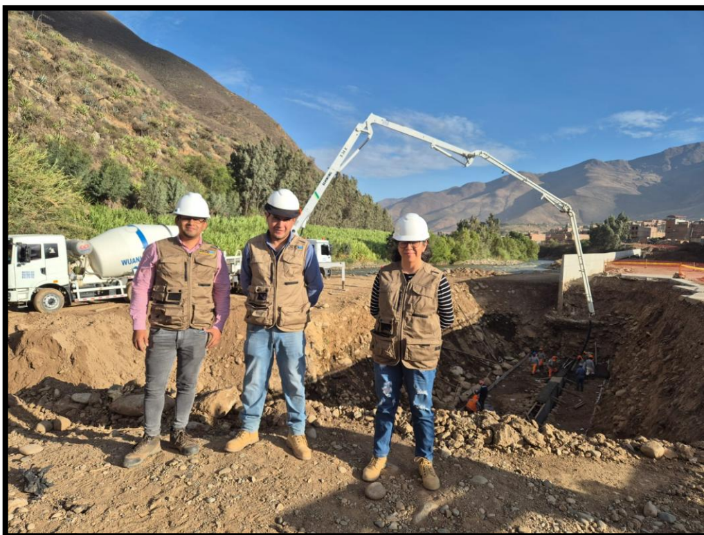
FOTOGRAFÍA N°06: CONTROL DEL VERTIDO DE CONCRETO DE SOLADO EN MURO DE CONCRETO ARMADO
